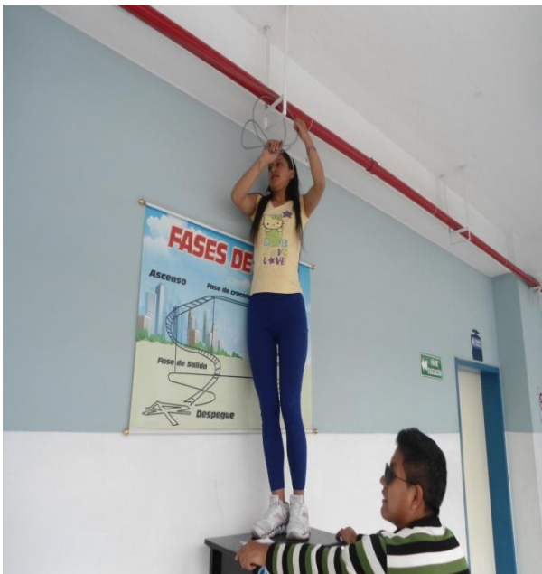
Imagen No.3: Implementación del cableado para la Red
