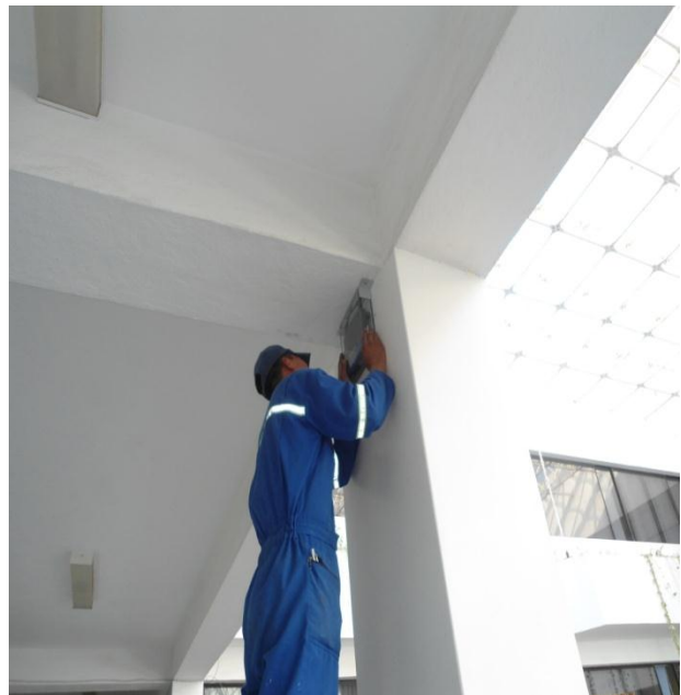
Imagen No.4: Colocación del AP
