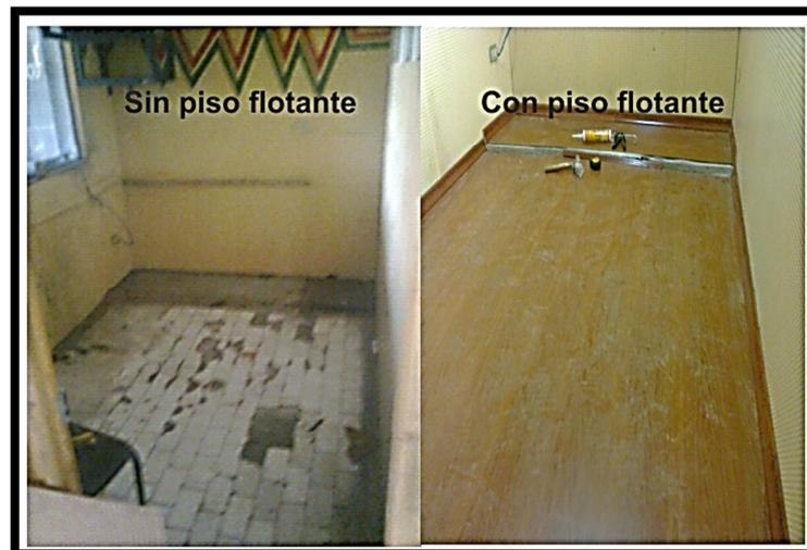
Figura No. 37 Instalación piso flotante [A]
