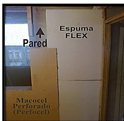
Figura No. 36 Instalación de aislamiento acústico [A]
