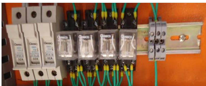
Figura 5.28.: Protección para el circuito de fuerza.
