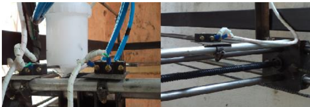
Figura 5.23.: Micros switch ubicados trasversalmente.
