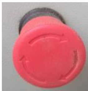
Figura 4.2.: Interruptor tipo hongo.
