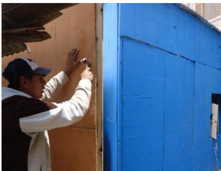
Figura 5.30.: Construcción de la cabina de pintura.
