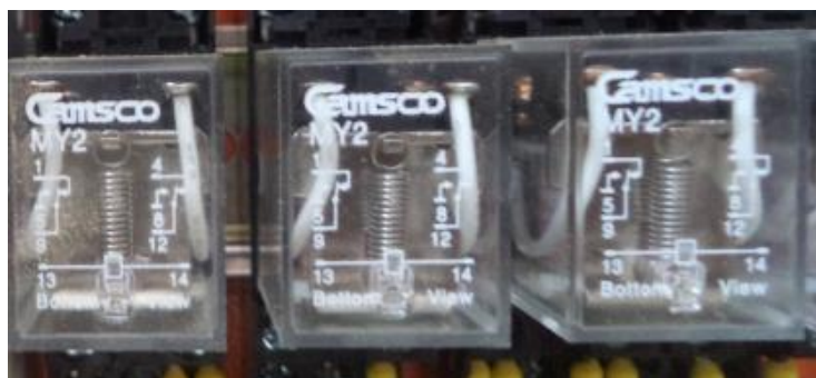
Figura 4.9.: Relés auxiliares con base incluida.
