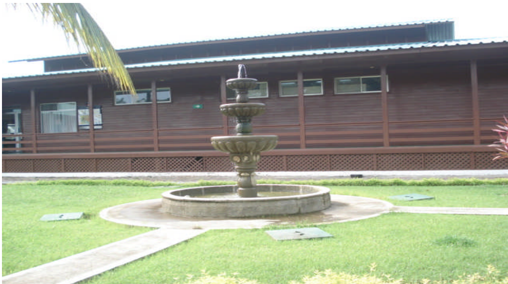
Fotografía: 5.1. Instalaciones del campamento permanente SPF Fuente: Autor 2007
