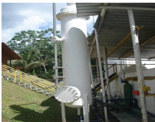
Fotografías: 4.20. Izq. y 4.21. Der. Tanque del filtro de carbón activo Fuente: autor 2007
