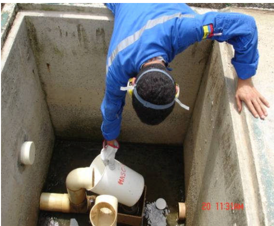
Fotografía: 7.4 del Anexo 16. Sistema de Desinfección Fuente: autor 2008
