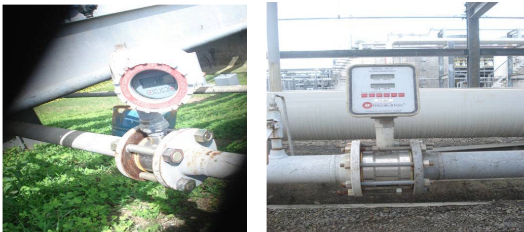
Fotografías: 4.28. Izq. Medidor del Agua Doméstica; 4.29. Der. Medidor del Total de Agua que Ingresa Fuente: autor 2007
