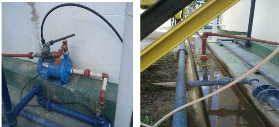
Fotografías: 4.26. Izq. Inf. Inyector, Y 4.27 Der. Inf. Difusor Fuente: autor 2007
