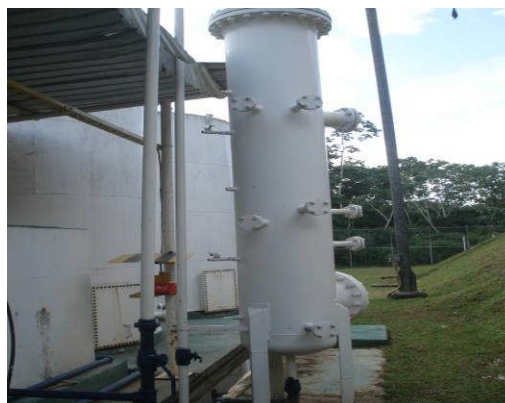
Fotografías: 4.20. Izq. y 4.21. Der. Tanque del filtro de carbón activo Fuente: autor 2007
