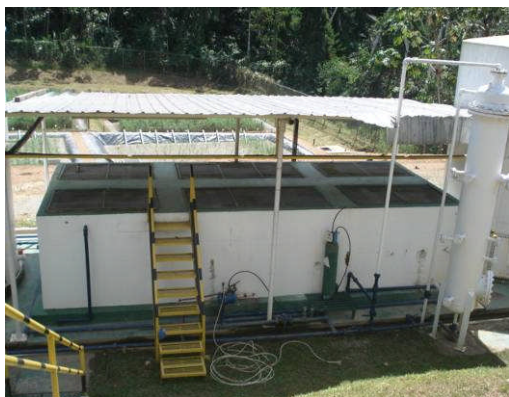
Fotografías: 4.18. Izq. y 4.19. Der. Tanque de Sedimentación Fuente: autor 2007
