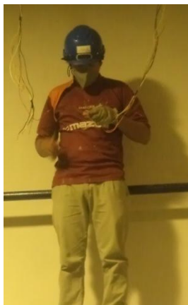
Figura 3.6: Empalme del cable.
