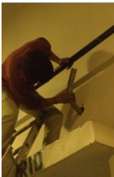
Figura 3.7: Colocación de tubo en el laboratorio.
