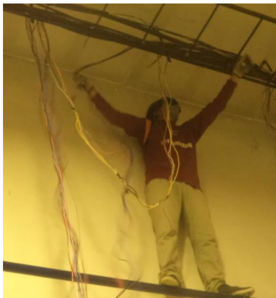
Figura 3.2: Colocación de cable en la canaleta principal.
