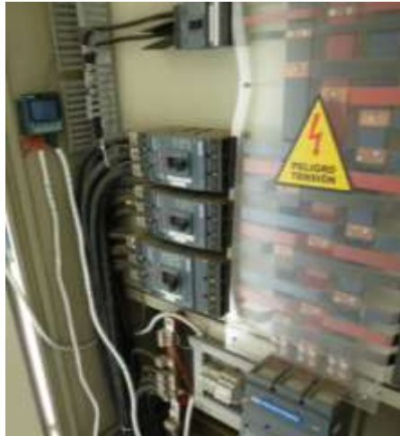
Figura 3.5: Implementación del medidor de parámetros eléctricos.
