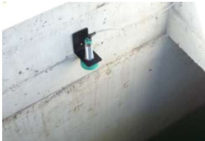
Figura 3.13: Implementación del sensor de nivel
