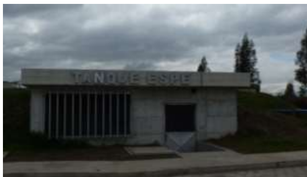
Figura 2.4: Tanque de agua campus politécnico
