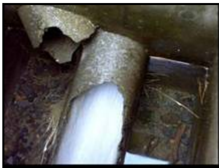
Figura. 3.5 Tubo de Asbesto cemento que conduce agua potable para Machachi
