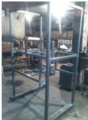
Figura 3.5: Estructura de la máquina esmaltadora terminada.
