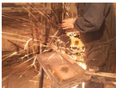
Figura 3.2: Corte de Tubería metálica.
