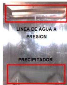
Figura 3.15: Montaje del sistema de cortina de agua.
