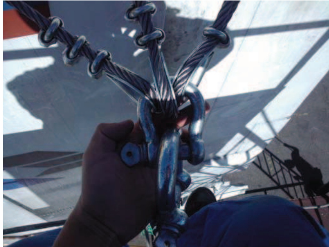
Figura 3.34: Grillete \frac{1}{2} común para los tres cables Fuente: Fernando Caicedo
