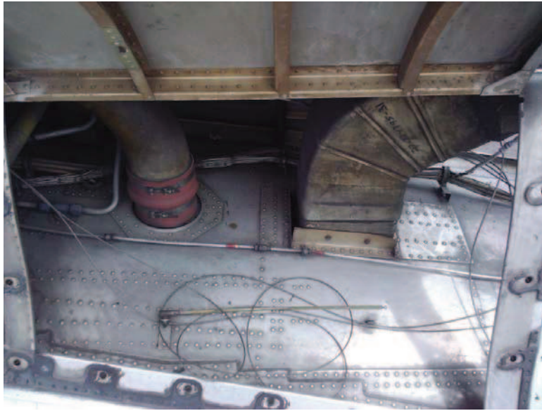
Figura 3.6: Cables tensores aflojados
