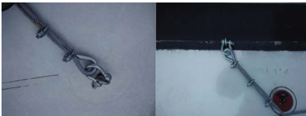
Figura 3.13: Eslinga colocada en los ganchos de sujeción. Fuente: Fernando Caicedo
