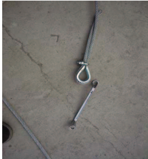
Figura 3.30: Pre ajuste de grapas Fuente: Fernando Caicedo
