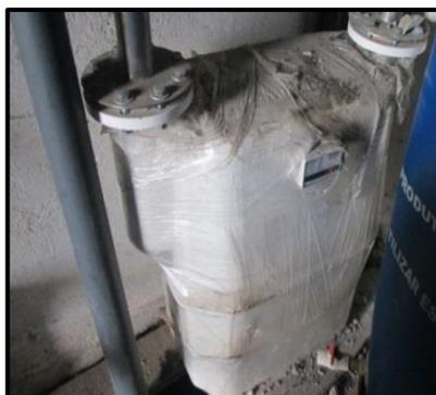
**Figura 3.15:** Caudalímetro de Biogas
