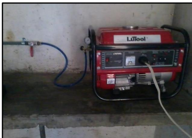
**Figura 5.6:** Motor-Generador LUTOOL conectado a los Consumidores
