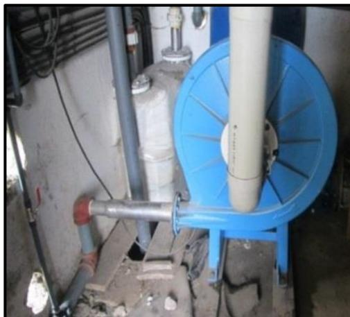
**Figura 3.17:** Soplador de Biogas
