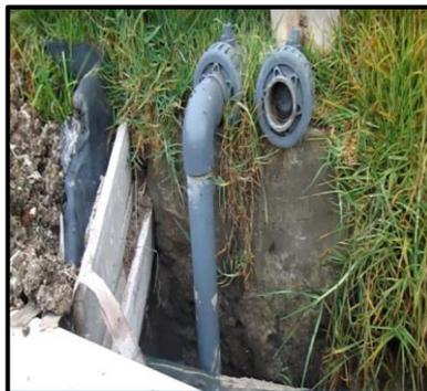
**Figura 3.14:** Trampa de Condensados
