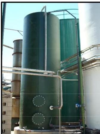
**Figura 3.18:** Biofiltro para remover el  $H_2S$  a nivel industrial
