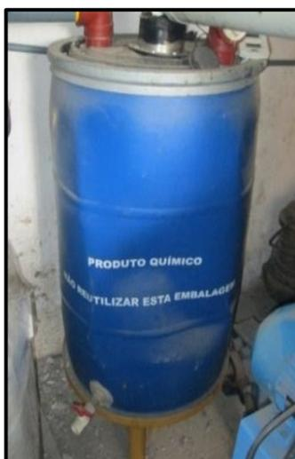
**Figura 3.19:** Filtro de limallas para remover  $H_2S$  del Biogas
