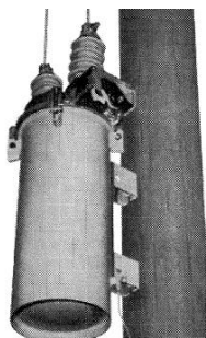
Figura 2.10 La instalación de polos superior de reconectador monofásico.
