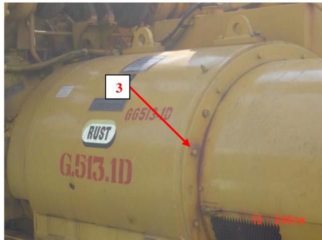
**Fig. 4.12 Punto de medición en el Generador, lado libre**
