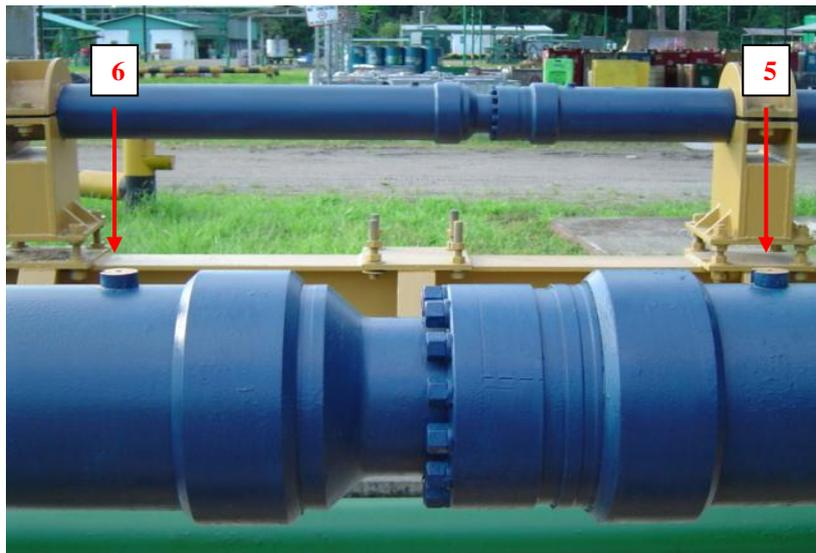
**Fig. 4.8 Punto de medición en la unión entre la Bomba 1 y 2**
