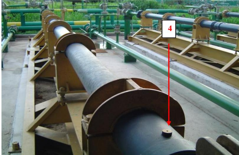
**Fig. 4.7 Punto de medición en Bomba 1, lado conducido**
