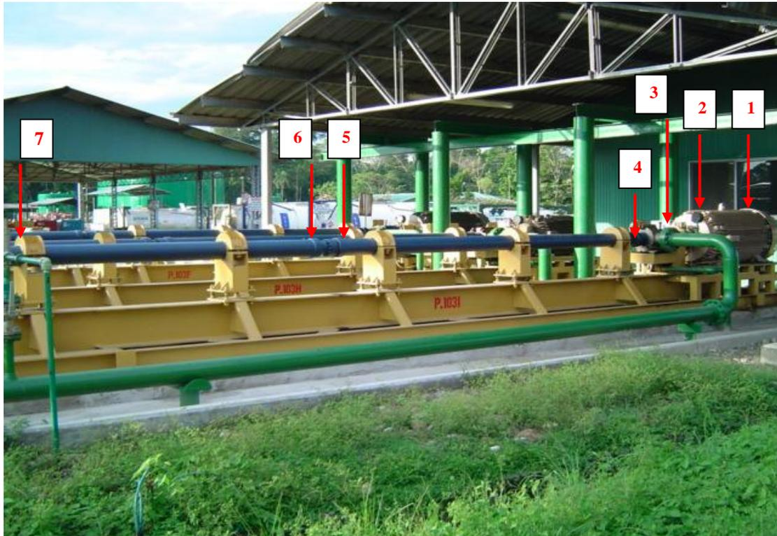
**Fig. 4.4 Puntos de medición en una bomba REDA**
