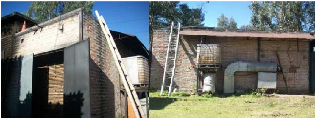
Figura 1.6: Cámara de Secado y Sistema de calentamiento
