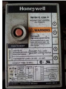
Figura 3.6: Control del quemador
