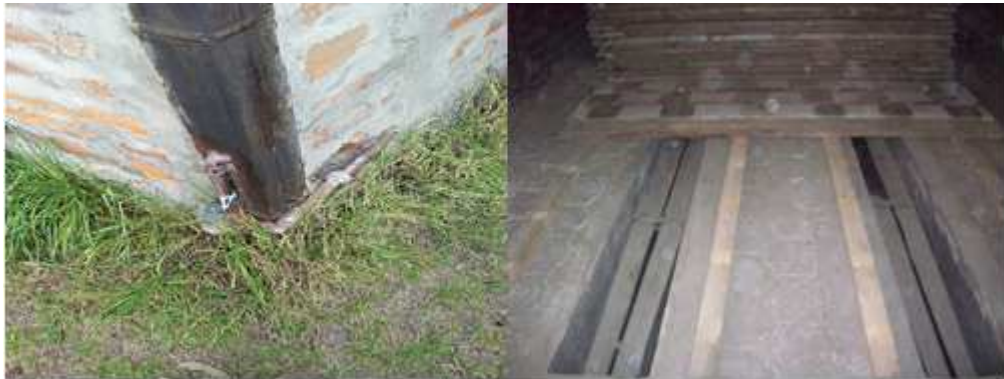
Figura 3.9: Estado de tubería y conductos
