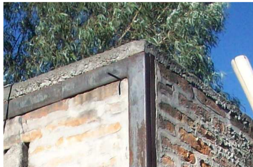
Figura 3.17: Conexión viga columna
