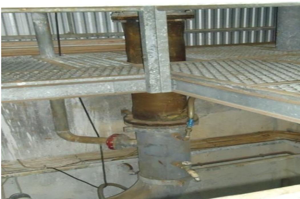
Figura 2.6. Mezclador estático.
