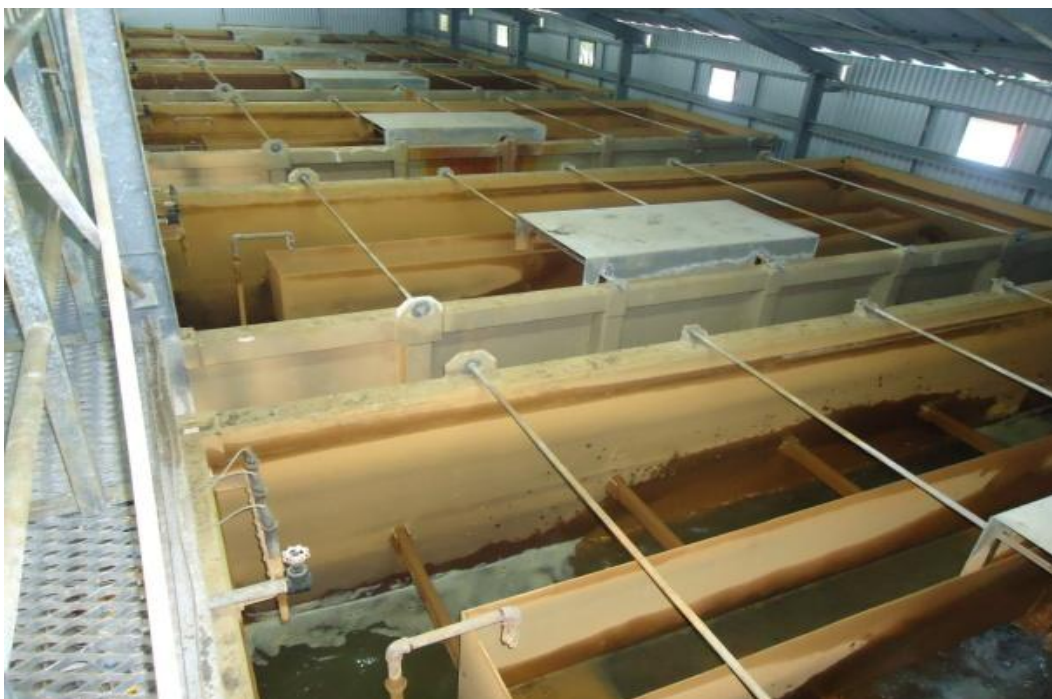
Figura 2.2. Depósitos filtrantes, vista superior.
