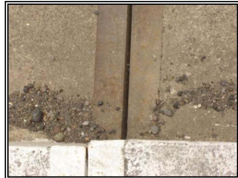
Desalineamiento de las capas del puente, sostenidas por una estructura que estaba cediendo. Enero 2005
