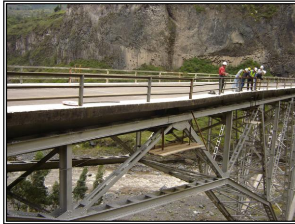
Vista puente de baños. Enero 2005
