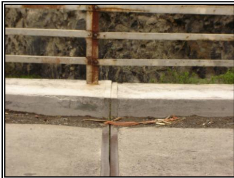
Desalineamiento de las capas del puente, sostenidas por una estructura que estaba cediendo. Enero 2005
