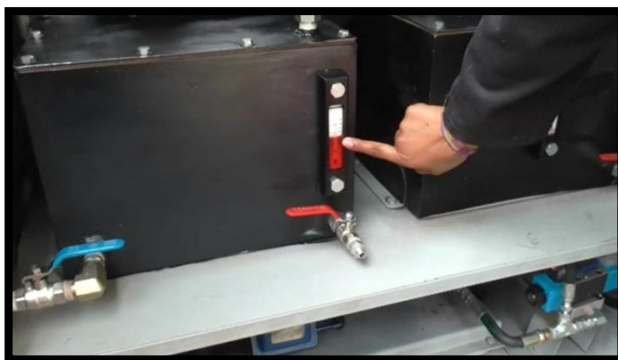
Figura 4. 56. Inspección del funcionamiento de la unidad. Fuente: Autores
