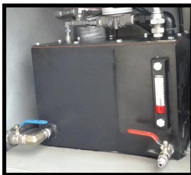
Figura 2. 12. Depósito no presurizado con respiradero
