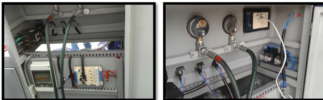
Figura 4. 44. Protección del sistema eléctrico y electrónico.
