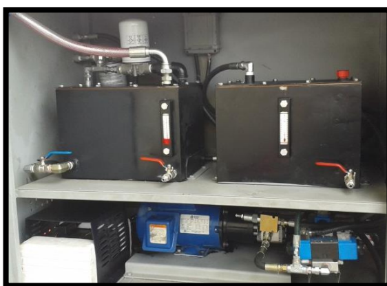
Figura 4. 31. Depósito de suministro A. Fuente: Autores
