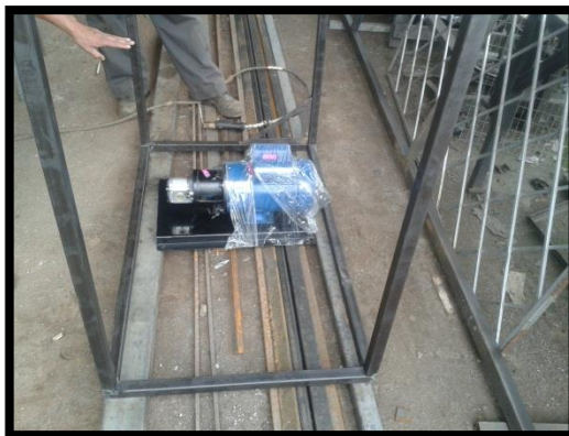
Figura 4. 2. Estructura metálica de 1/1/4" Fuente: Autores
