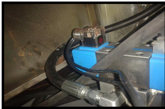
Figura 4. 33. Conexión eléctrica de las electroválvulas. Fuente: Autores
