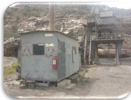
Fig. 76: Distribuidor de mezcla asfáltica.
