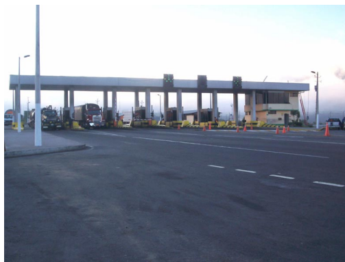
Figura 4.43 Estación de Peaje de Aloag
