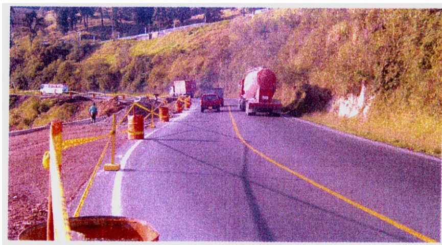
Figura 3.3. Foto Rehabilitación carretera Aloag – Santo Domingo
