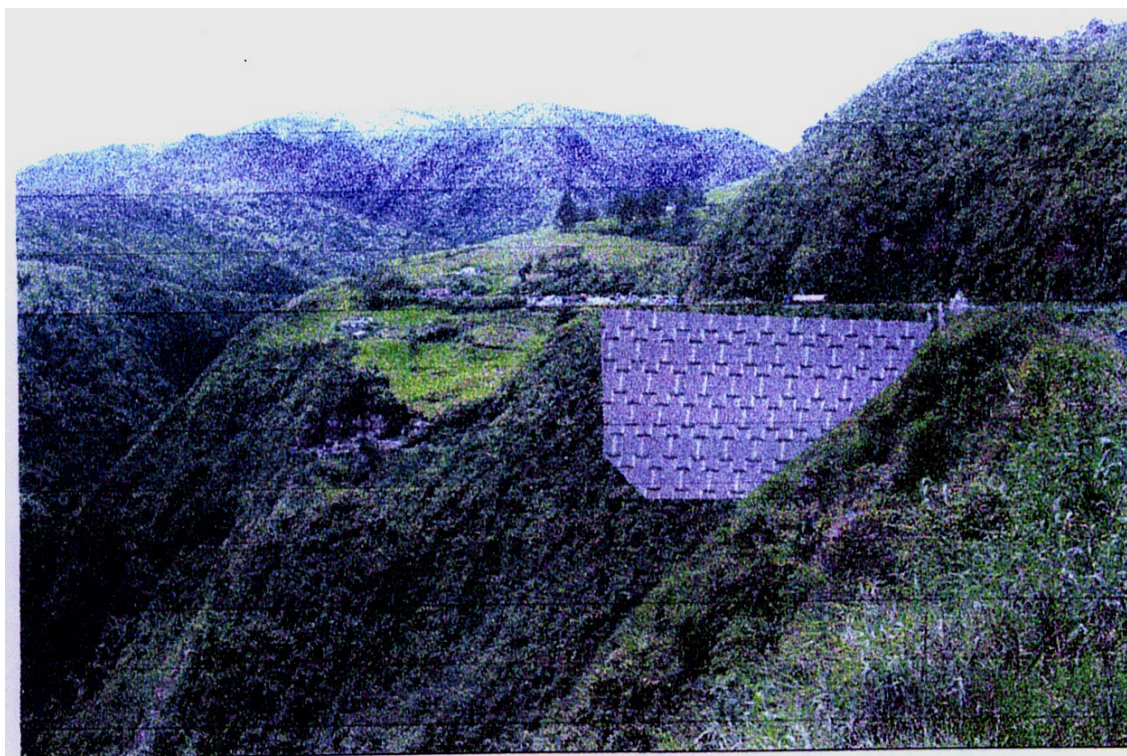
Figura 3.7. Foto Geopantallas prefabricadas de hormigón
