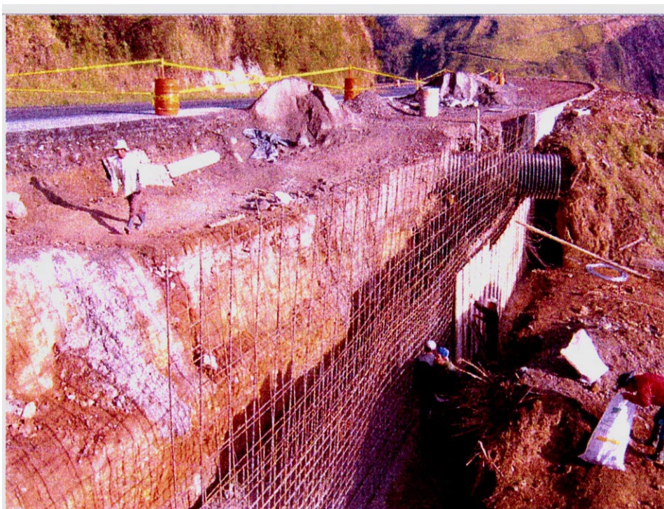
Figura 3.4. Foto Ampliación Carretera Aloag – Santo Domingo.
