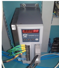
Figura 4.46 Montaje del servo drive.
