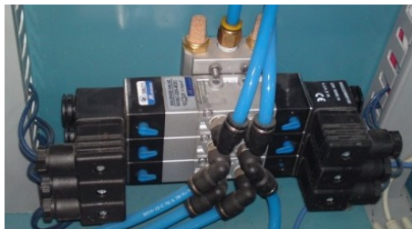
Figura 4.35 Montaje de electroválvulas.
