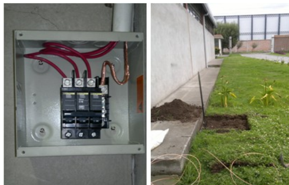
Figura 5.15 Construcción de la puesta a tierra.
