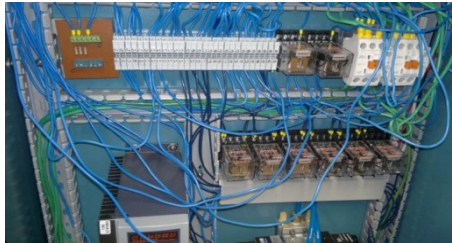
Figura 4.43 Instalación de relés y contactores.
