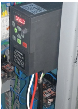
Figura 4.56 Instalación del variador de frecuencia.
