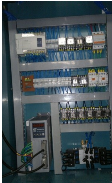
Figura 4.58 Instalación completa del tablero eléctrico.
