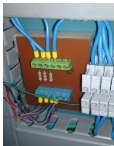
Figura 4.54 Instalación de resistencias de 1.8 K \Omega .
