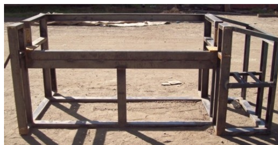
Figura 4.3 Estructura soporte terminada.
