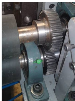
Figura 5.6 Inspección visual a los engranes.
