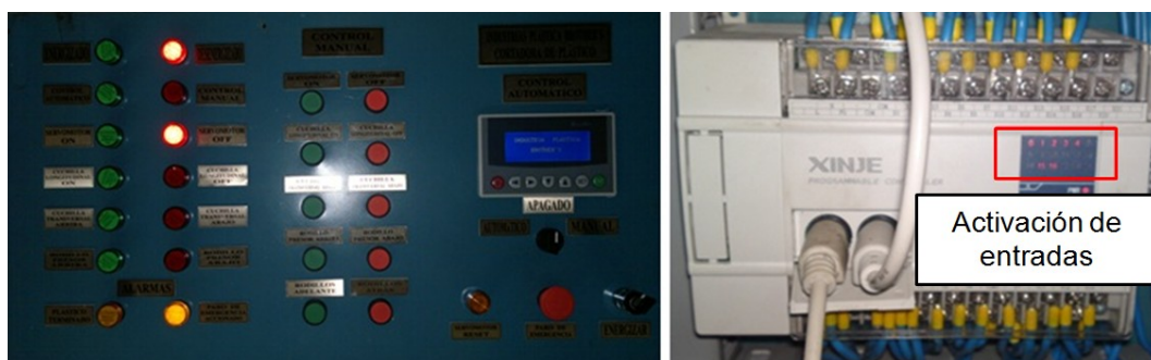
Figura 5.11 Verificación de conexión del tablero de mando - PLC.
