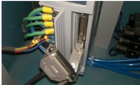
Figura 4.51 Cable de comunicación PLC - Servo drive.
