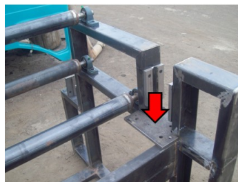
Figura 4.20 Montaje de placas base.
