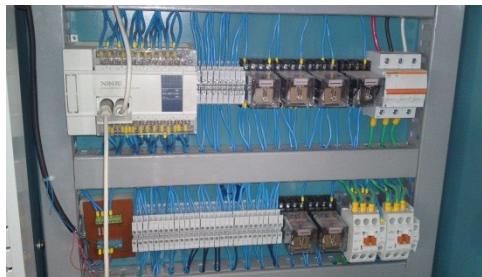
Figura 5.12 Verificación de conexiones del tablero eléctrico.
