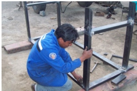
Figura 4.1 Construcción de la estructura soporte.
