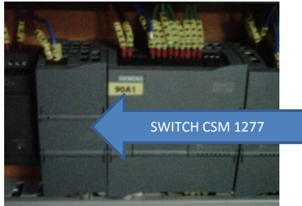
Figura 3.36. Montaje del módulo Switch CSM 1277.
