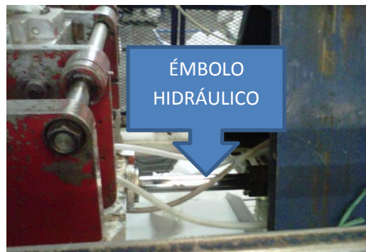
Figura 2.6. Émbolos hidráulicos instalados.
