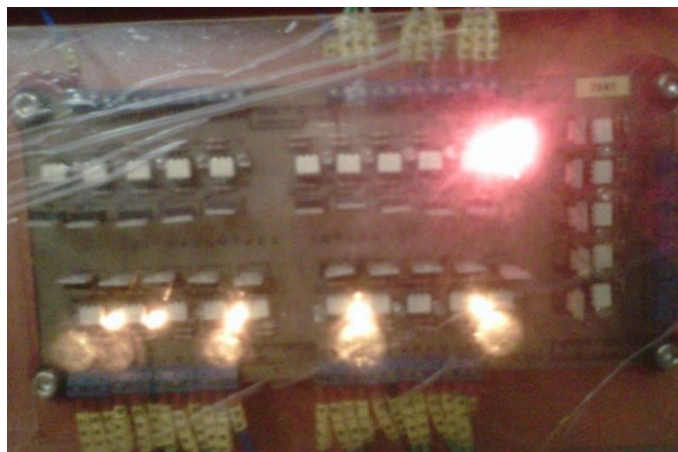
Figura 4.1. Pruebas de control de electroválvula hidráulica y neumática.
