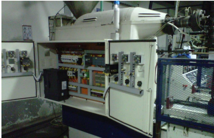
Figura 3.28. Montaje del tablero de control en la máquina extrusora – sopladora.
