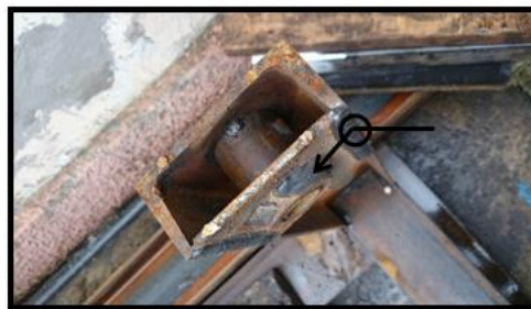
Figura 4. 12: Colocación del bocín del brazo de elevación
