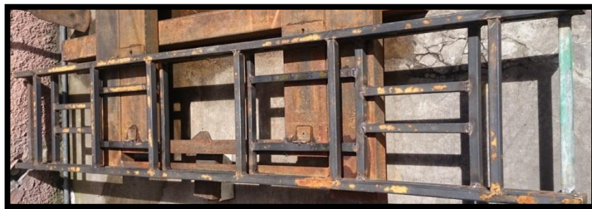
Figura 4. 20: Construcción de plataformas
