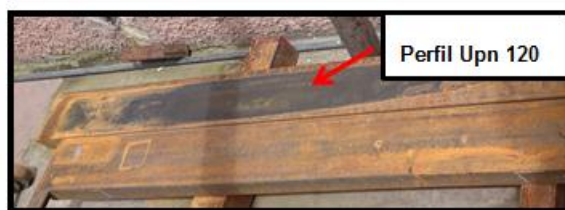
Figura 4. 2: Estructura base en UPN 160
