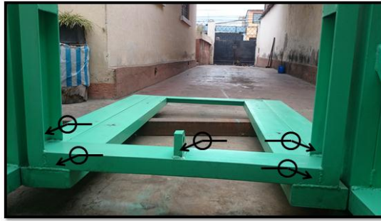
Figura 4. 13: Soldadura postes y soporte de cilindro hidráulico
