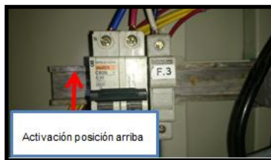
Figura 4. 37: Activación termo magnético central
