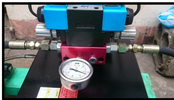
Figura 4. 28: Acoplamiento de mangueras del circuito hidráulico
