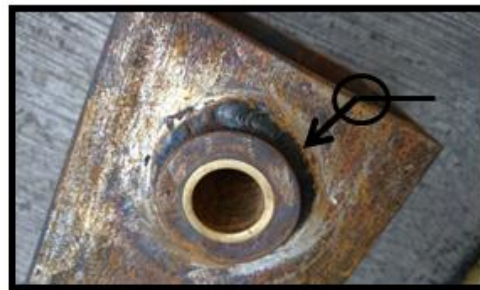
Figura 4. 4: Colocación del bocín de rodamiento
