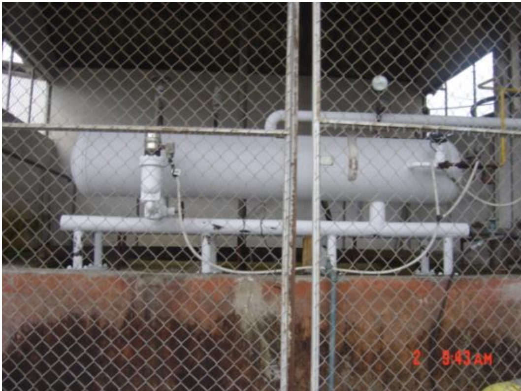
FIG3.13. BANCO DE HIELO Y EVAPORADOR PARA AMONIACO
