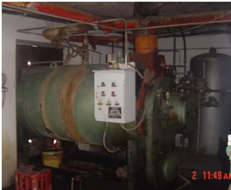
FIG3.14. CALDERA MARCA CONTINENTAL PARA LA PRODUCCIÓN DE VAPOR
