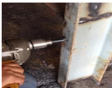
Figura 4. 34 Perforación del perfil UPN160 Elaborado por: Carrera C. & Cepeda W.
