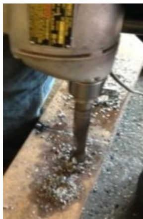
Figura 4. 24 Perforación perfil IPN Elaborado por: Carrera C. & Cepeda W.
