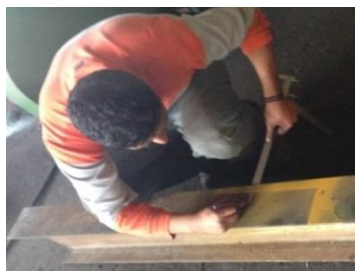
Figura 4. 22 Medida de profundidad perfil IPN Elaborado por: Carrera C. & Cepeda W.
