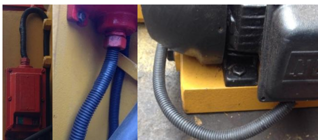
Figura 4. 84 Colocación de manguera corrugada Elaborado por: Carrera C. & Cepeda W.
