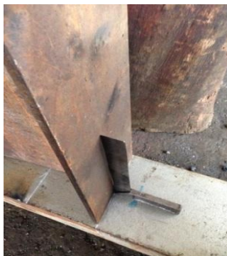
Figura 4. 31 Ubicación perfil IPN con el perfil UPN160 Elaborado por: Carrera C. & Cepeda W.
