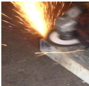
Figura 4. 30 Eliminación de rebabas perfil UPN160 Elaborado por: Carrera C. & Cepeda W.
