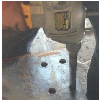
Figura 4. 10 Perforación perfiles IPN Elaborado por: Carrera C. & Cepeda W.
