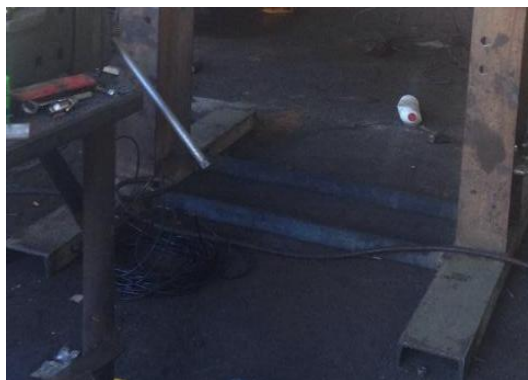
Figura 4. 37 Parte inferior armada Elaborado por: Carrera C. & Cepeda W.
