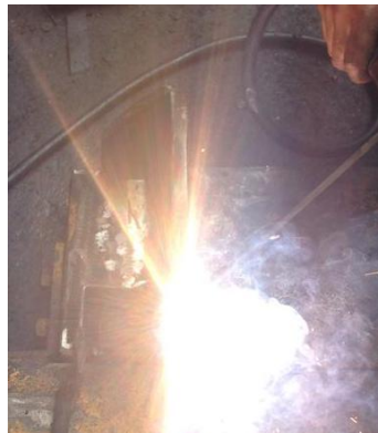
Figura 4. 64 Soldadura de bases en el perfil IPN Elaborado por: Carrera C. & Cepeda W.
