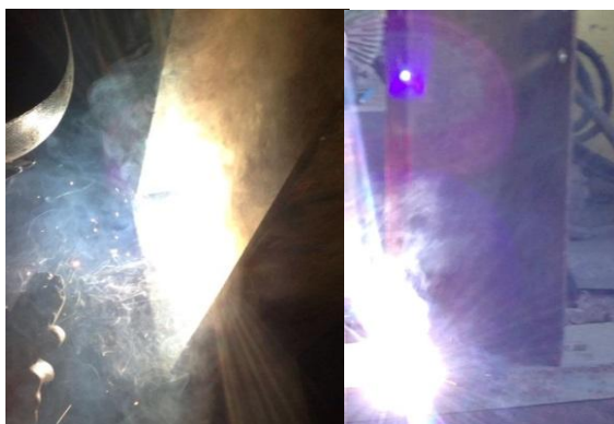
Figura 4. 32 Soldadura de perfil IPN con el perfil UPN160 Elaborado por: Carrera C. & Cepeda W.
