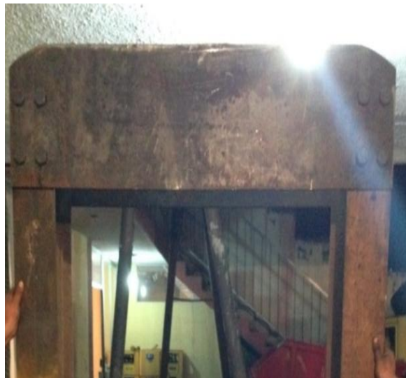
Figura 4. 13 Parte superior armada Elaborado por: Carrera C. & Cepeda W.
