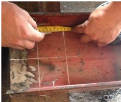
Figura 4. 20 Medición para perforación Elaborado por: Carrera C. & Cepeda W.
