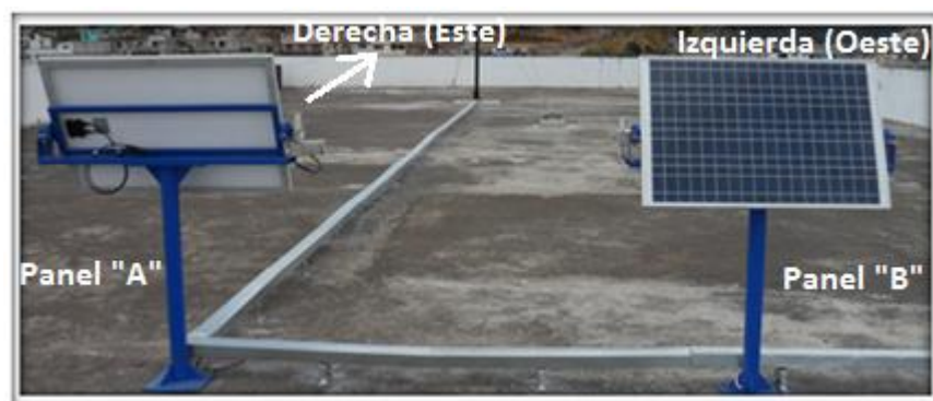
Figura 4.7: Verificación del movimiento de los paneles fotovoltaicos
