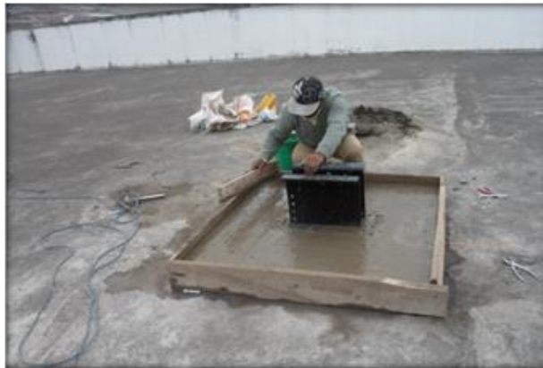
Figura 3.7: Base de concreto del aerogenerador
