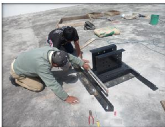
Figura 3.6: Base de la torre del aerogenerador
