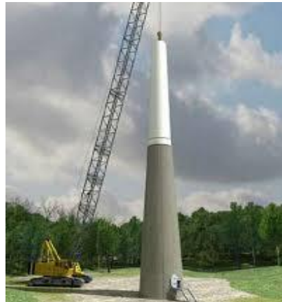
Figura 2.11: Torre de hormigón
