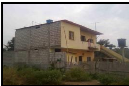
Figura N° 51: Vivienda de Hormigón Armado
