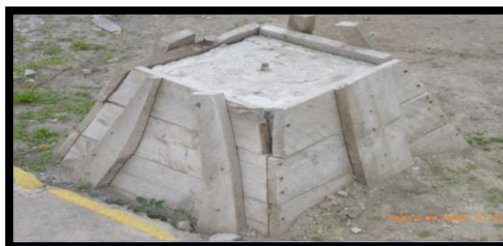
Figura Nº 8: Mojón de red geodésica ubicado en el Cantón Chambo
