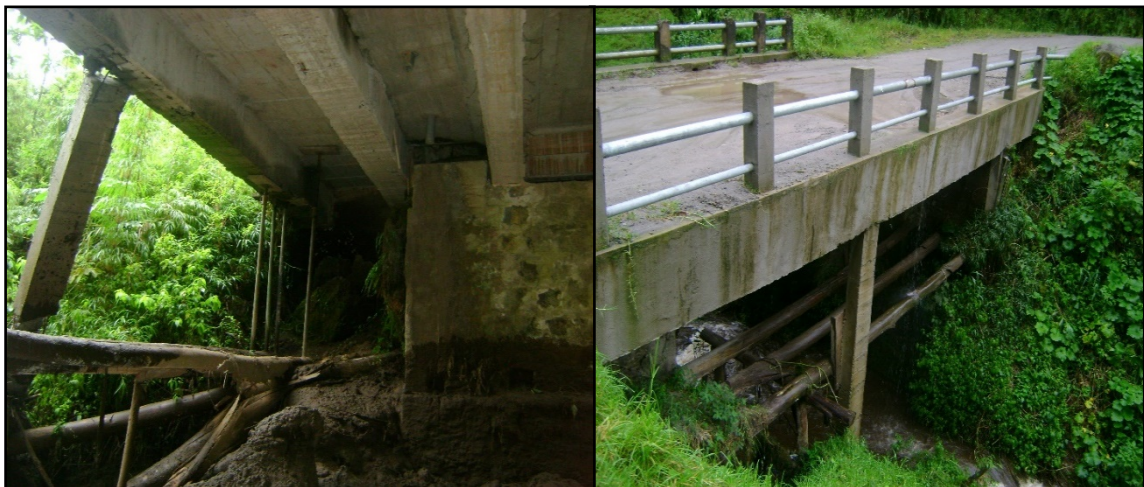
Ilustración 10 Reparación puente GAD Atahualpa
