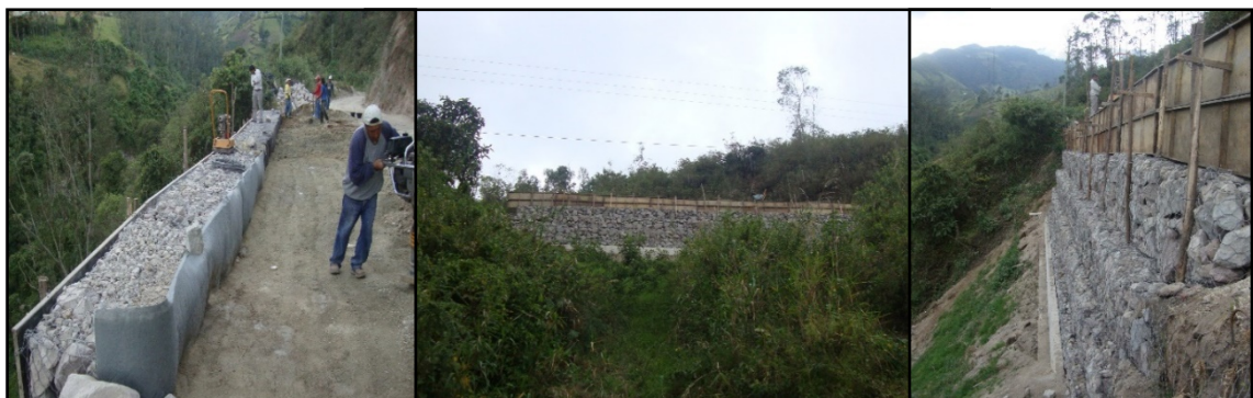
Ilustración 14 Muro de Gaviones GAD Atahualpa
