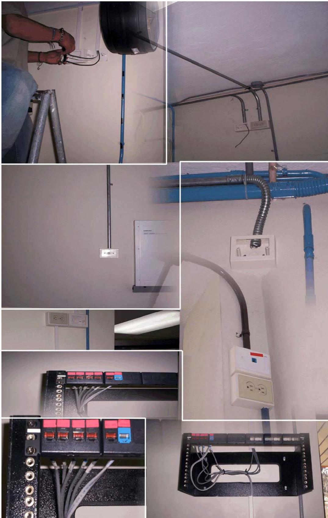
Figura. 5. 22. Instalación de los puntos de red, patch panels.
