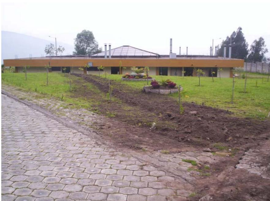
**Figura. 5. 7. Conducto subterráneo para instalación del enlace entre Metrología y Química.**
