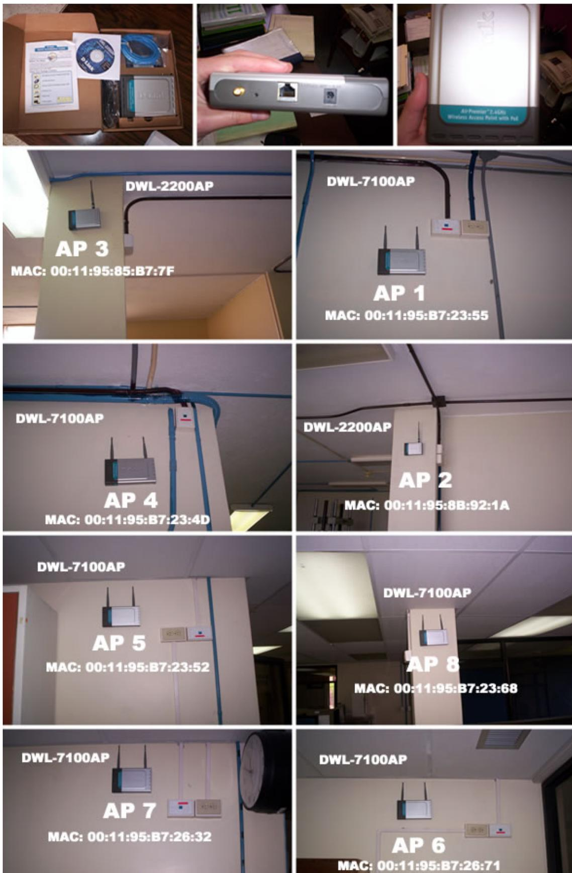
Figura. 5. 25. Instalación y ubicación de Access Points.
