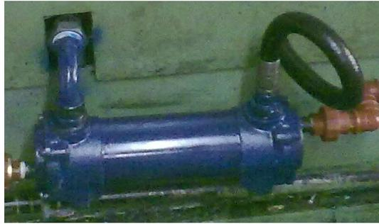
**Figura 142. Intercambiador instalado luego de su mantenimiento.**
