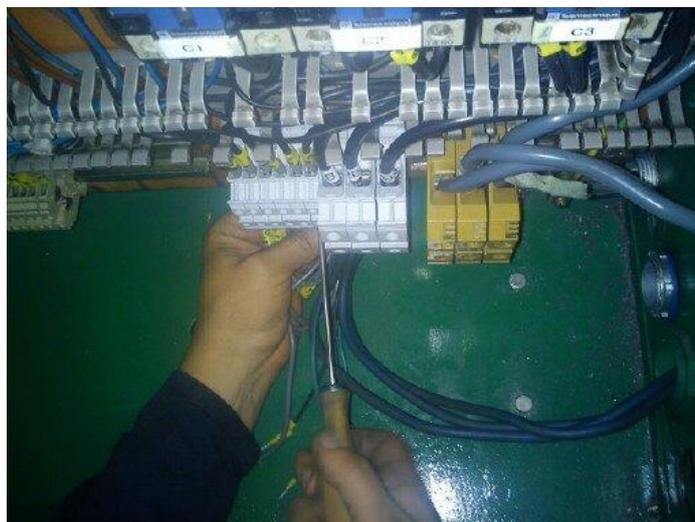
**Figura 213. Conexión de cables provenientes del motor de 15 HP.**
