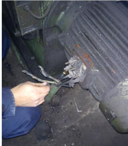
**Figura 49. Conexión de los devanados del motor eléctrico.**
