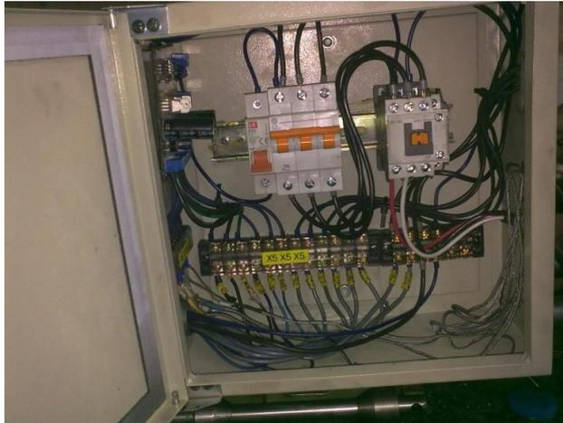
**Figura 214. Armado del gabinete secundario.**
