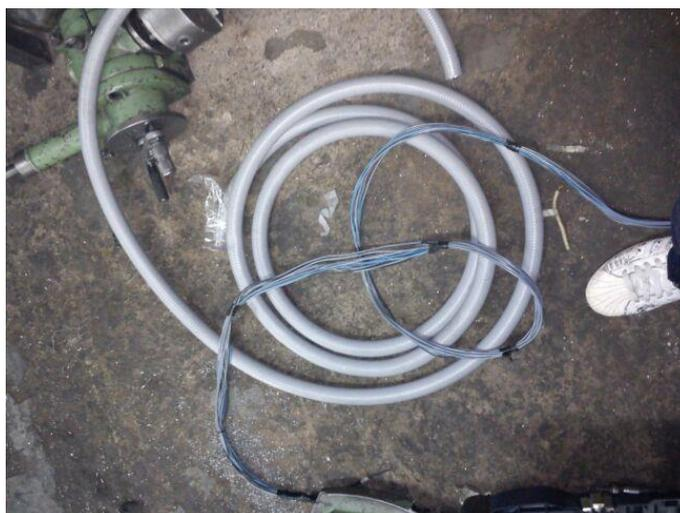
**Figura 212. Colocación de cables en manguera.**
