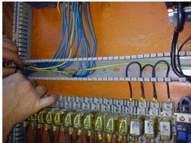
**Figura 199. Conexión de cables de control hacia relés.**
