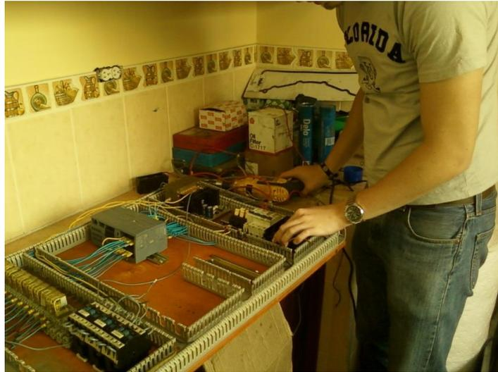
**Figura 200. Conexión de protecciones para motor M1 y niquelinas.**
