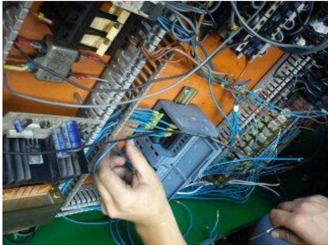
**Figura 198. Conexión de entradas y salidas.**
