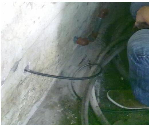
**Figura 136. Perforaciones en la pared para cable de conexión del motor y para tubería.**
