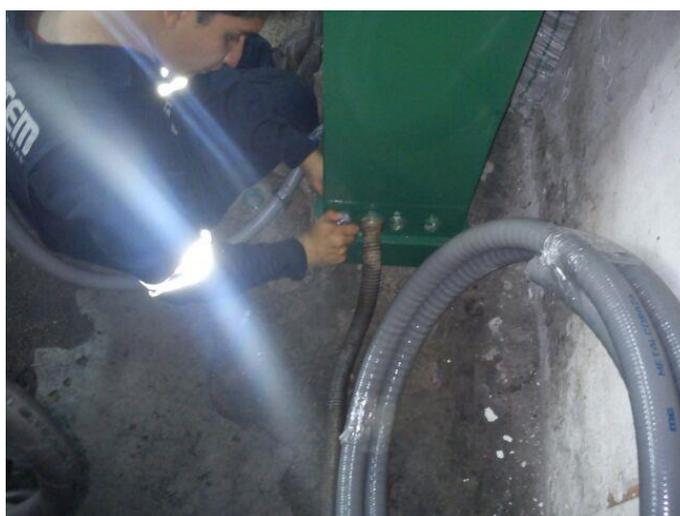
**Figura 211. Colocación de conectores de mangueras en gabinete principal.**
