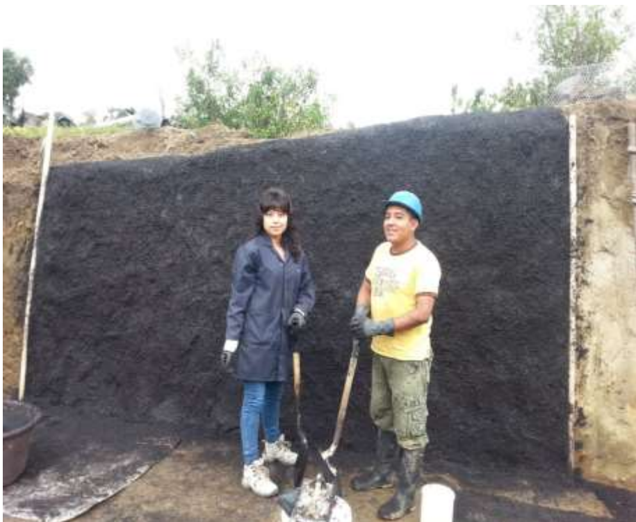
Figura 5.17 Finalización de la ubicación del mortero asfáltico (Autores)
