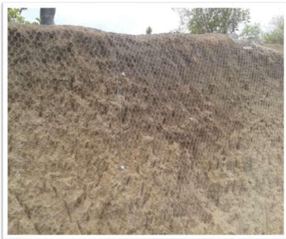
Figura 5.11 Talud con la malla colocada y anclada (Autores)
