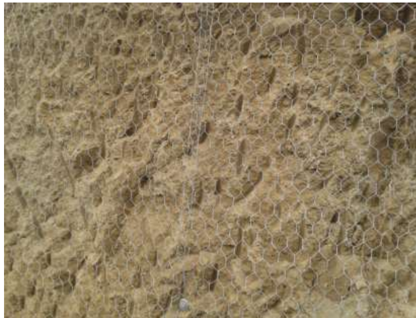
Figura 4.8 Malla utilizada en el talud (Autores)
