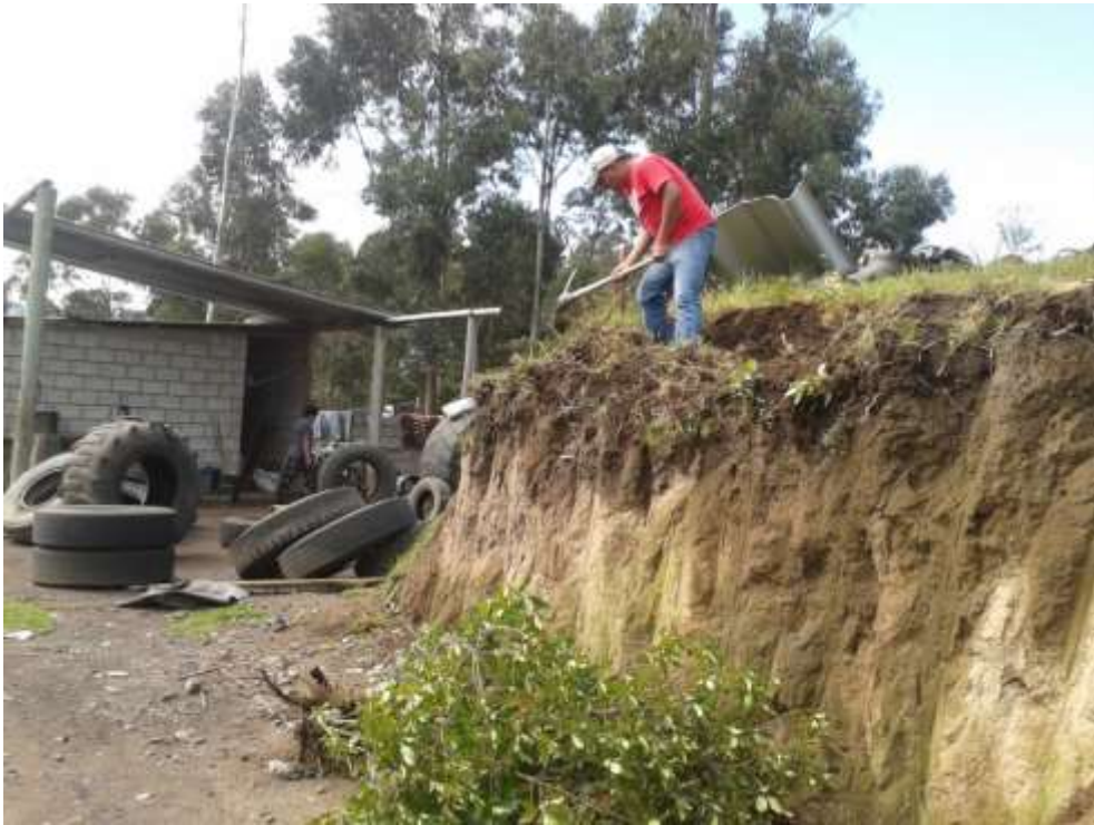
Figura 5.4 Eliminación de vegetación del talud (Autores)
