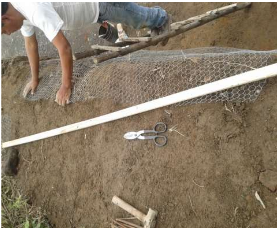
Figura 5.8 Colocación de malla (Autores)
