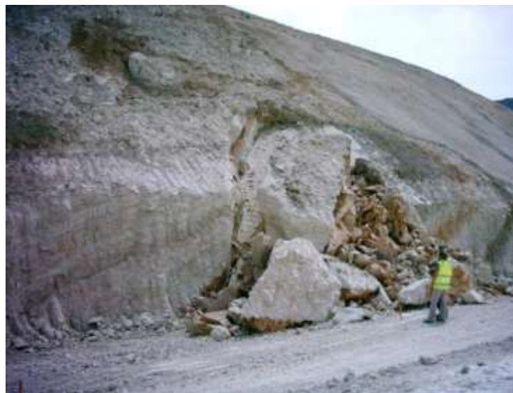
Figura 2.13 Falla por bloque (www.ingeroc.com)
