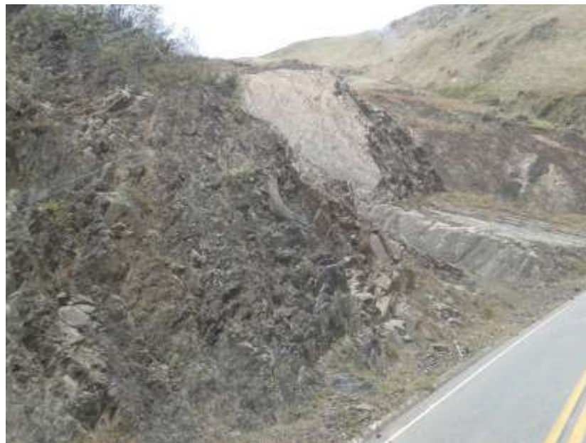
Figura 3.5 Fenómenos que ocurren en los taludes (Autores)
