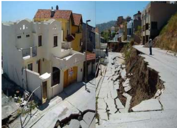
Figura 2.2 Falla por efecto del aumento de peso unitario del suelo ( www.elementos.buap.mx )
