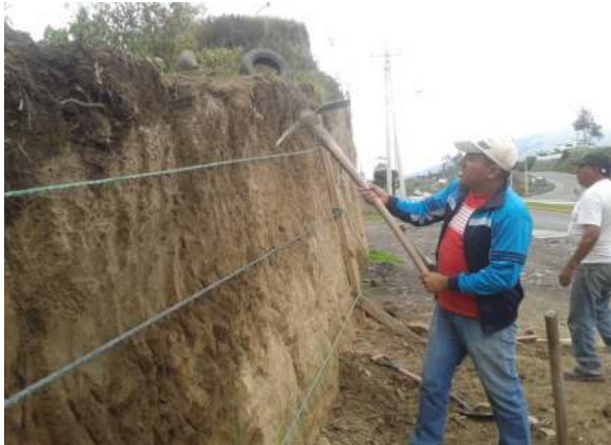
Figura 5.6 Nivelación y perfilado del talud (Autores)
