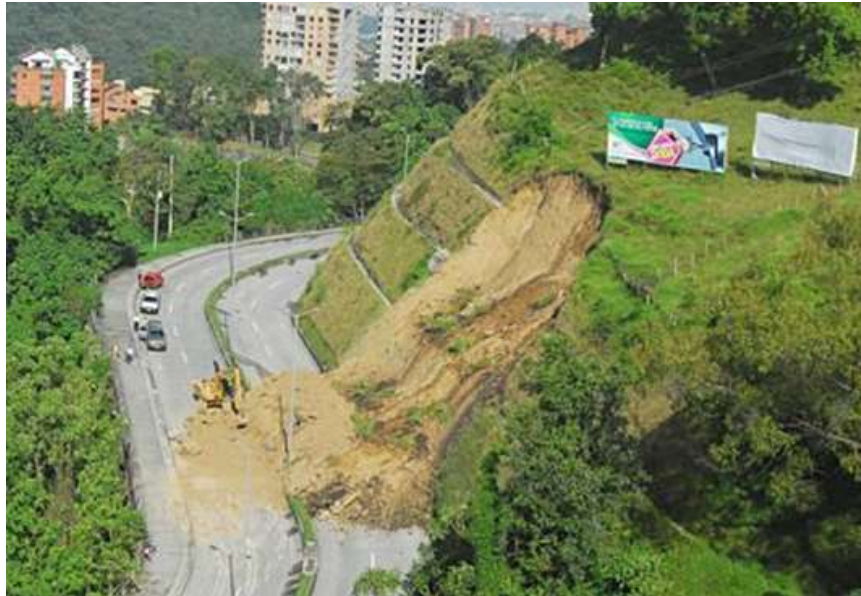
Figura 2.8 Falla rotacional en un talud artificial (smpmanizales.blogspot.es)
