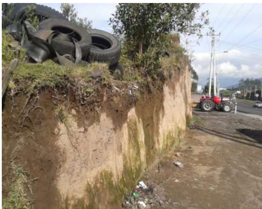
Figura 5.1 Talud estado inicial (Autores)
