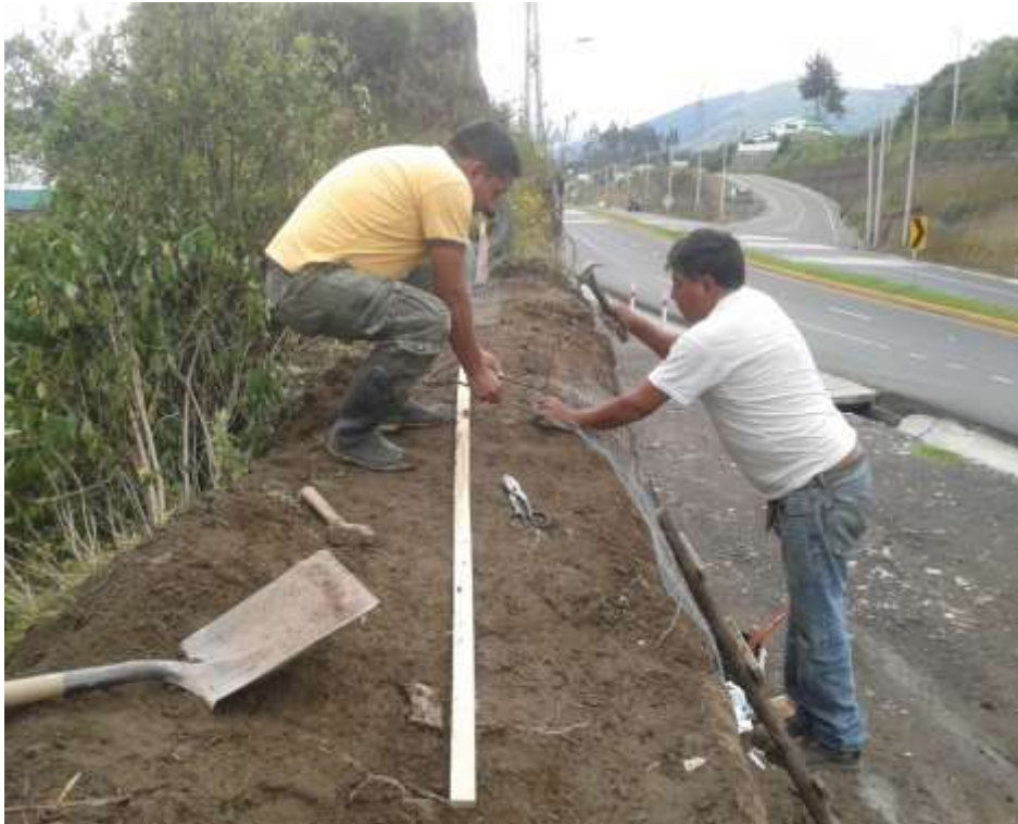
Figura 5.9 Colocación de malla parte superior del talud (Autores)
