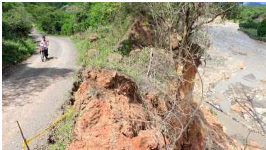
Figura 2.3 Expansión de las arcillas por absorción de agua ( www.laopinion.com.co )
