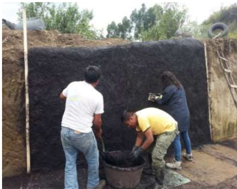
Figura 5.15 Colocación de la segunda capa del mortero asfáltico (Autores)
