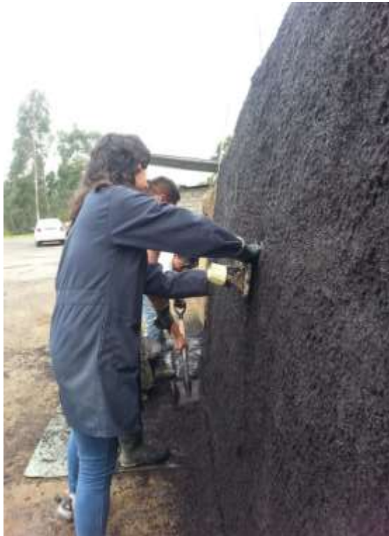
Figura 5.16 Colocación de la 3 capa de mortero asfáltico (Autores)
