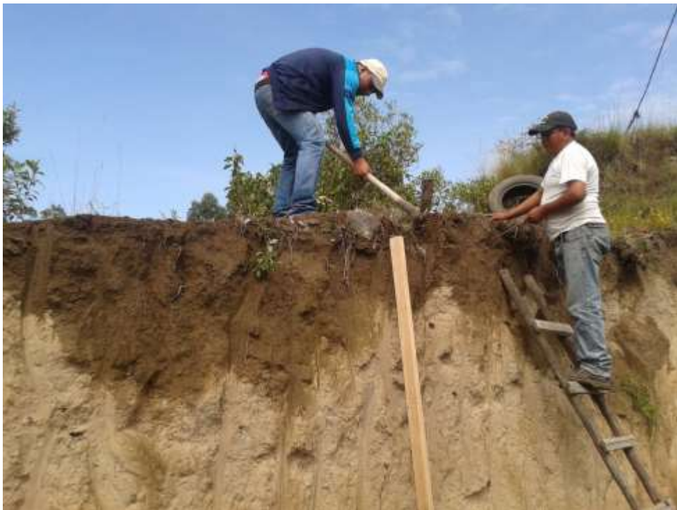
Figura 5.5 Talud después de la limpieza y desbroce (Autores)
