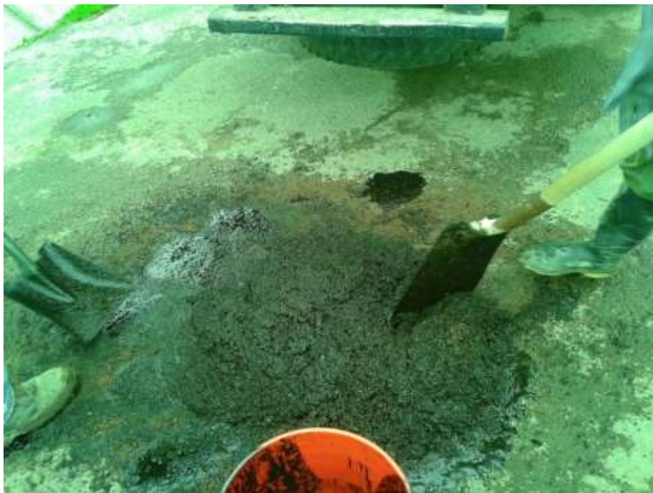
Figura 5.13 Elaboración de la mezcla in-situ (Autores)
