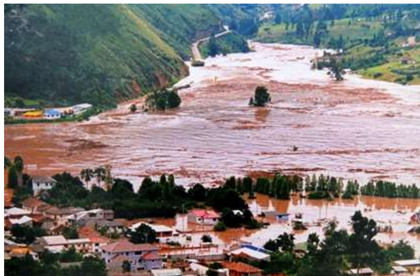
Figura 3.8 Devastación de poblaciones y construcciones Ecuador ( www.agua.gob.ec )
