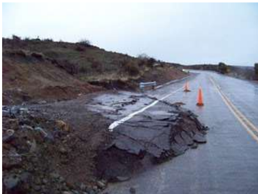
Figura 2.12 Falla traslacional en talud artificial (www.puertae.blogspot.com)
