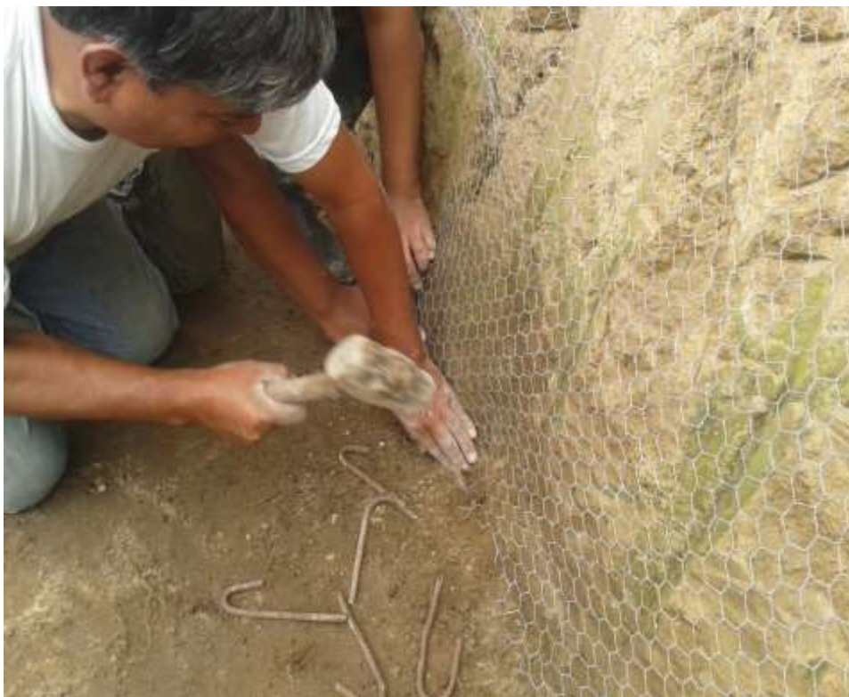
Figura 5.10 Ubicación de varillas para anclar la malla (Autores)
