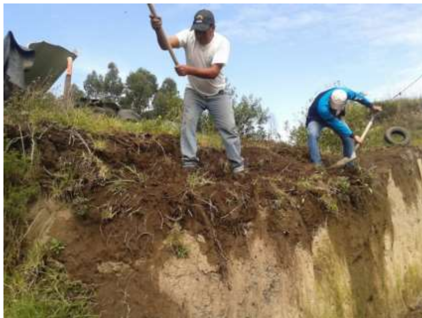
Figura 5.3 Limpieza del talud (Autores)
