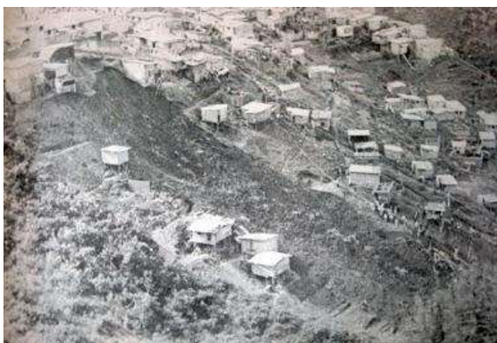
Figura 3.10 Deslizamiento en San Cayetano (www.elcomercio.com)
