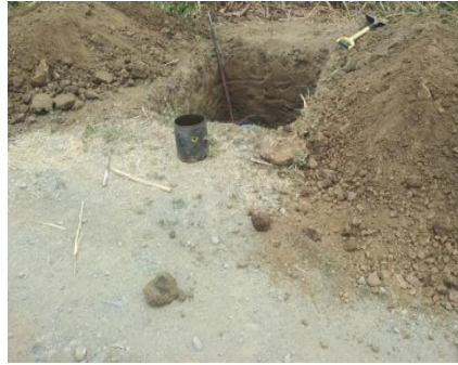
Figura 2.8 Muestra inalterada, tramo (Dm 34.000 al Dm 35.000)
