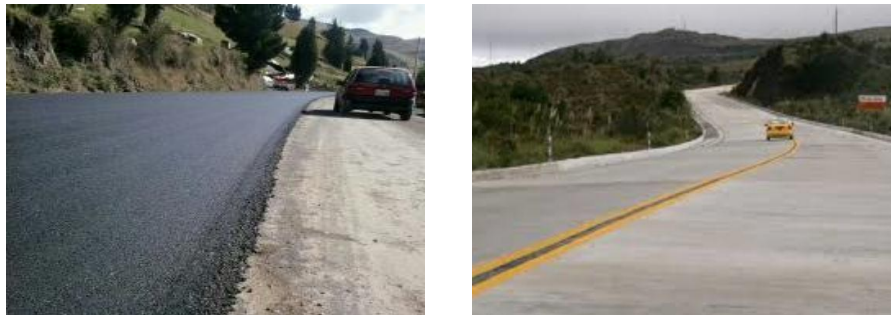
Figura 3.1: Pavimento Flexible y Rígido Elaborado por: Capt Diego López.
