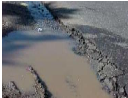
Figura 1.15: Desintegración de bordes
