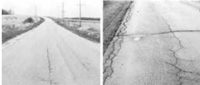
Figura 1.6: Fisuración longitudinal
