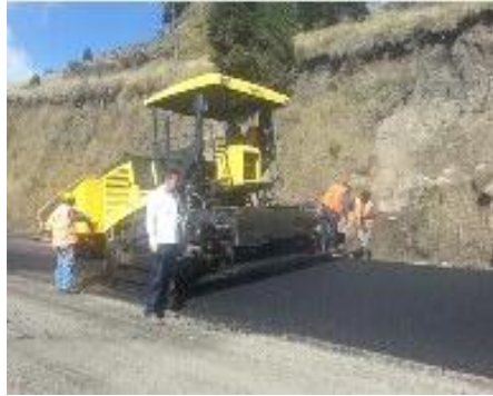
Figura 3.3: Tendido de Pavimento Flexible. Elaborado por: Capt. Diego López.
