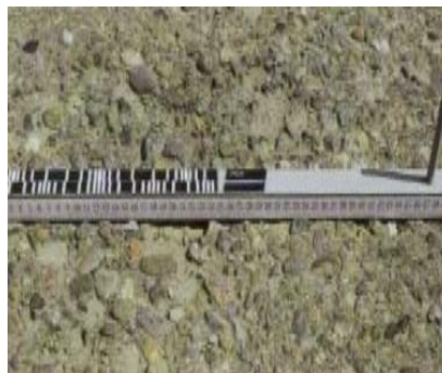
Figura 1.14: Peladura
