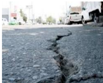
Figura 1.7: Fallas por corte
