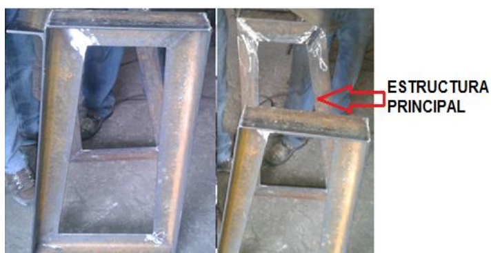
Figura 67. Fabricación: Estructura principal.
