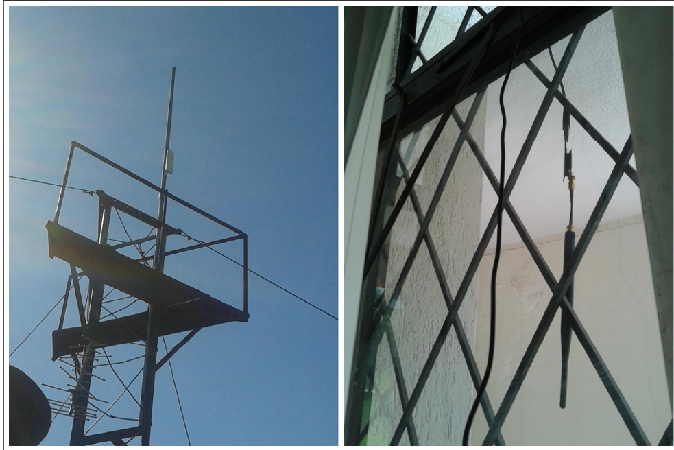
Figura 43: Instalación de equipos.
