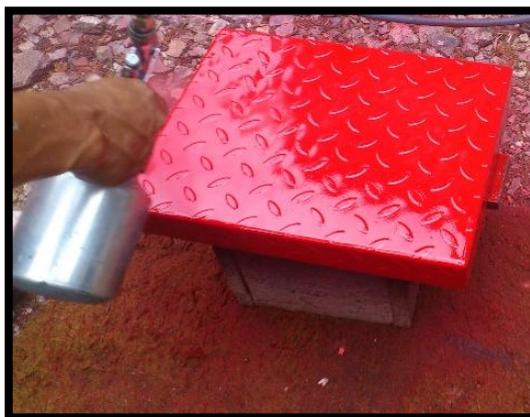
**Figura 4. 7. Aplicación de pintura - Bandejas cobertoras**
