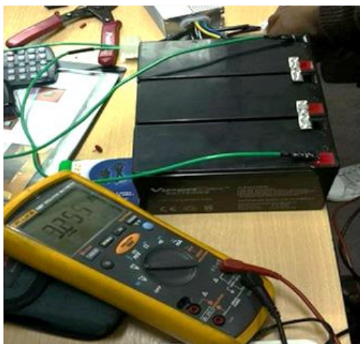
Figura 3. 4: Conexión en serie de baterías de la misma marca y modelo
