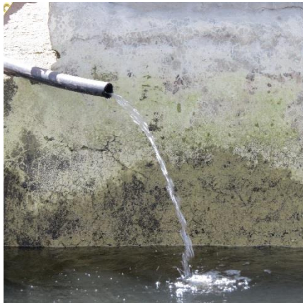
Fig. 6. Caudal a 48 voltios.
