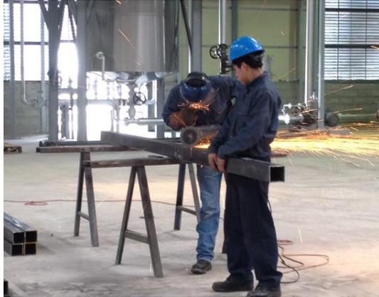
*Figura 67. Corte de los perfiles*
