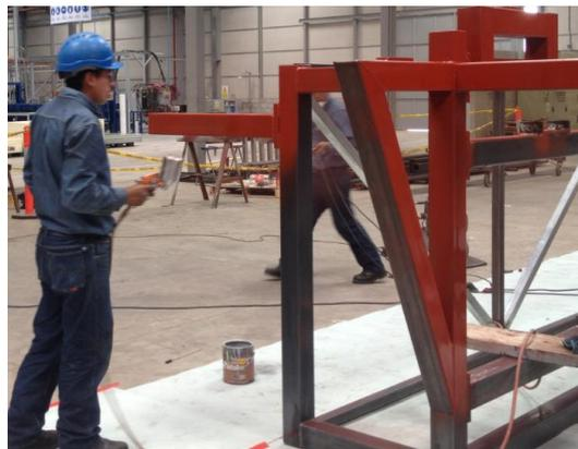
*Figura 91. Base anticorrosiva (fondo) en toda la estructura*
