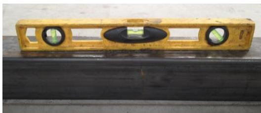
*Figura 69. Verificación de nivel del perfil con respecto al suelo*
