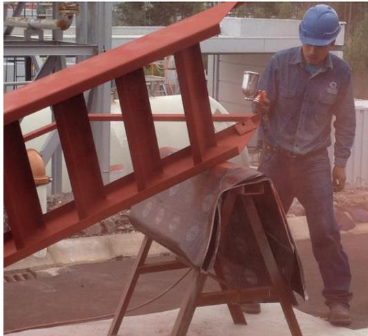
*Figura 93. Pintura en las gradas de acceso externo*
