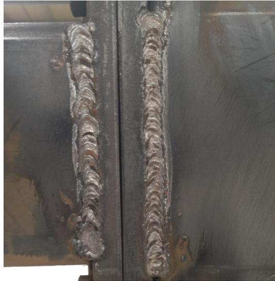
*Figura 76. Refuerzo en la soldadura con electrodos 6010/7018*
