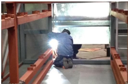
*Figura 106. Suelda interna en el sistema de enfriamiento*
