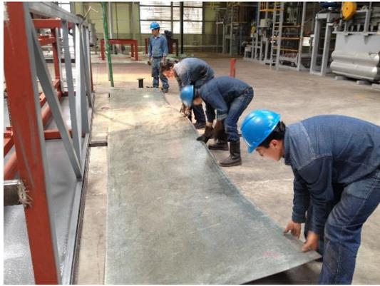
*Figura 104. Colocación planchas de acero galvanizado en el sistema de enfriamiento*
