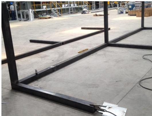
*Figura 71. Ensamble de columnas y vigas principales del bastidor*
