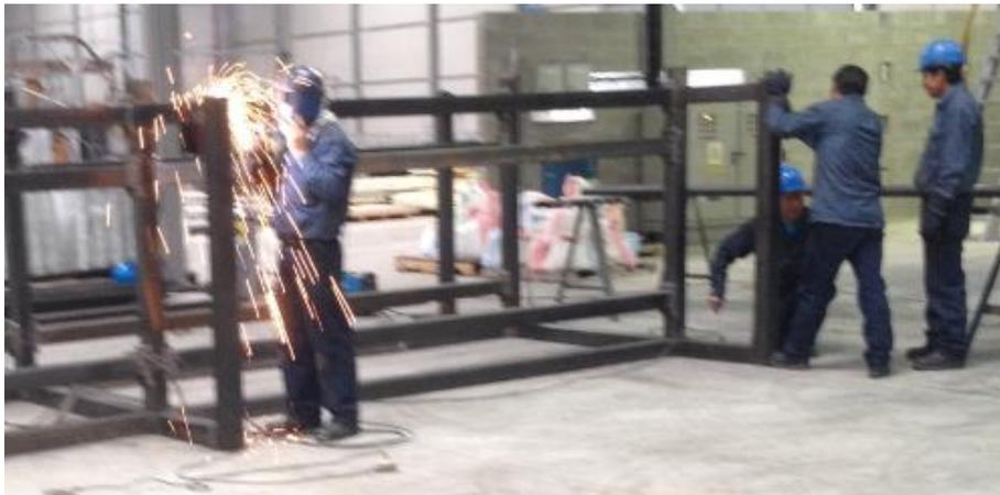
*Figura 79. Elaboración de los cuartos de máquinas*
