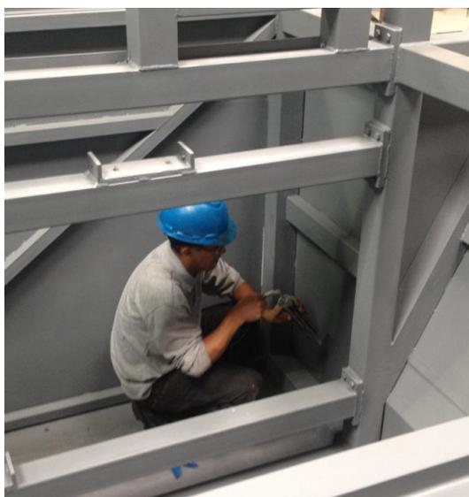
*Figura 110. Sellado de posibles fugas de agua*
