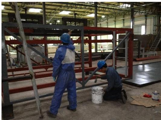
*Figura 103. Pintura naval en el sistema de enfriamiento*
