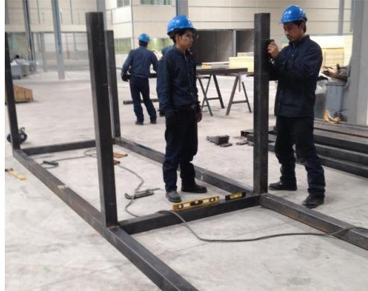
*Figura 73. Medición y trazado en columnas del bastidor*
