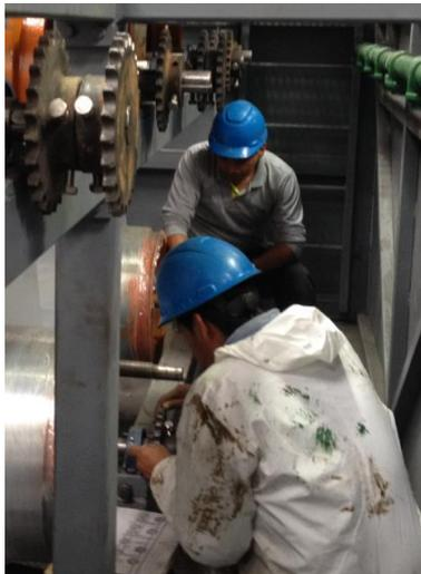
*Figura 122. Instalación del sistema de transmisión*
