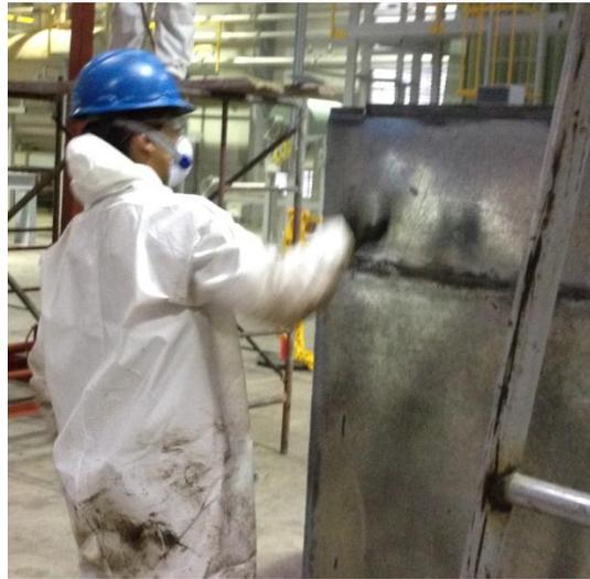
*Figura 114. Colocación del galvanizado en frío.*
