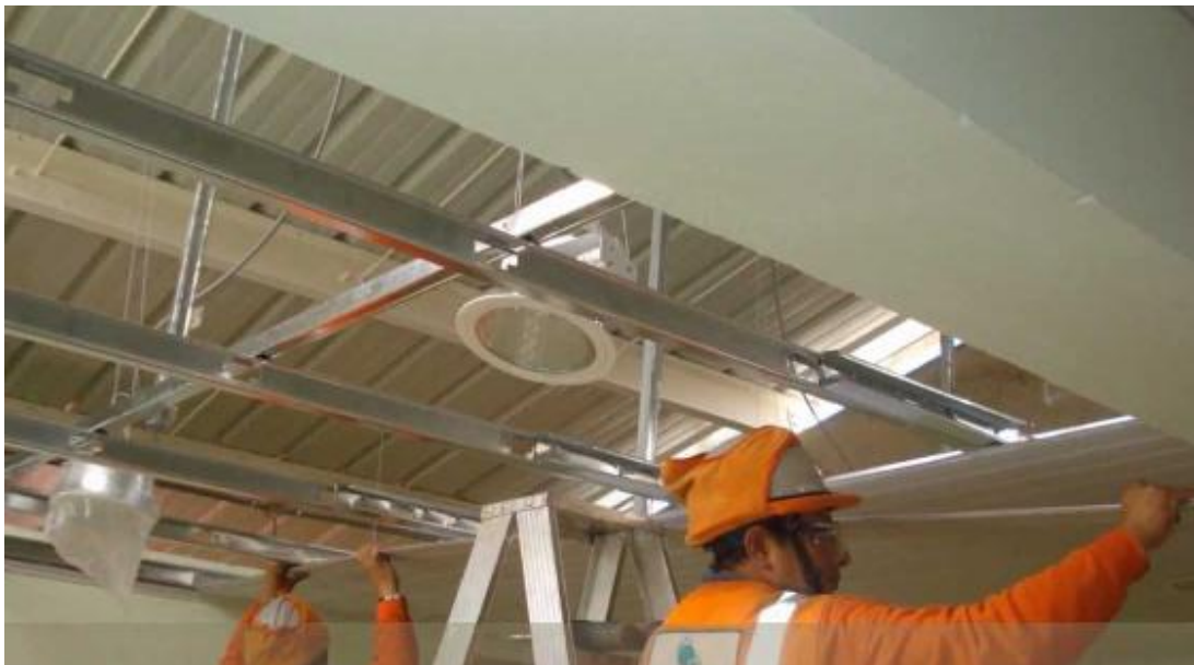
Figura 2. Montaje de cielo raso para cubrir estructuras
