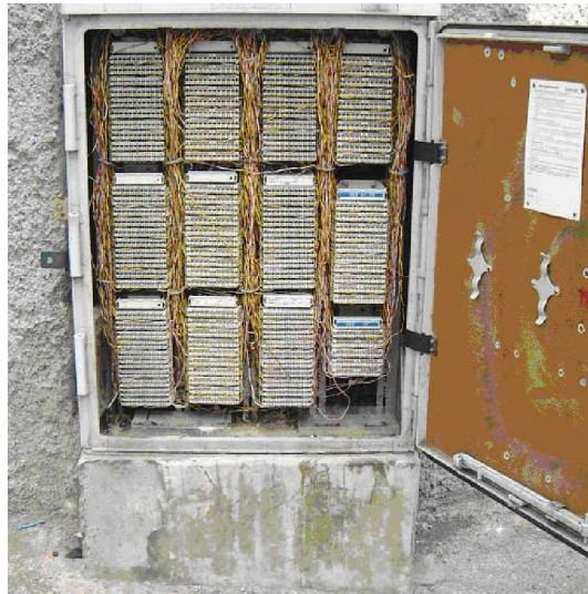
Figura 1.31 (b) Armario Telefónico
