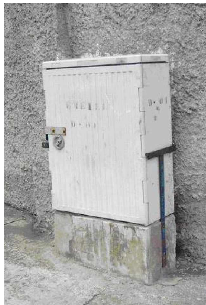
Figura 1.31 (a) Armario Telefónico
