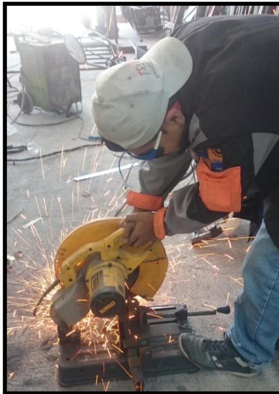
**Figura 123,** Corte de perfil tubular mediante disco de corte.
