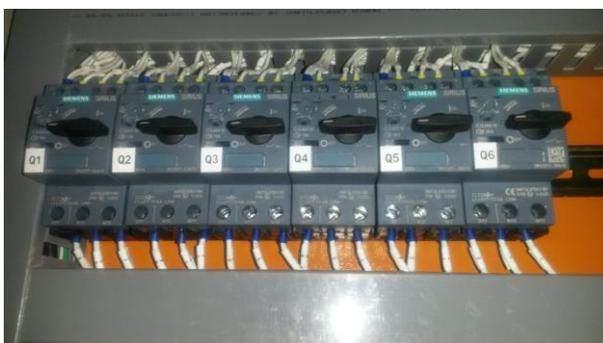
**Figura 89 Conexión de relés térmico 3RV20 11.**
