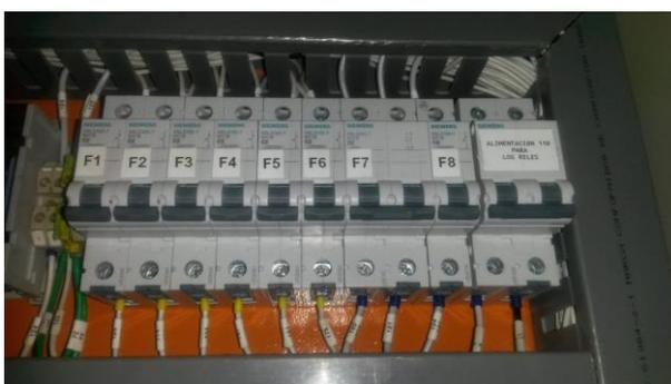
**Figura 90 Conexión de Portafusibles.**
