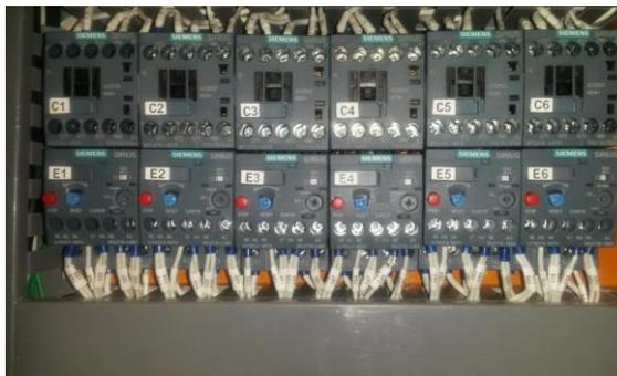
**Figura 88 Conexión de contactores 3RT2015 y Relés térmicos 3RU2116**
