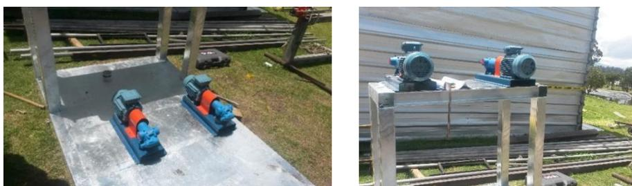
**Figura 74 Montaje de Bombas.**
