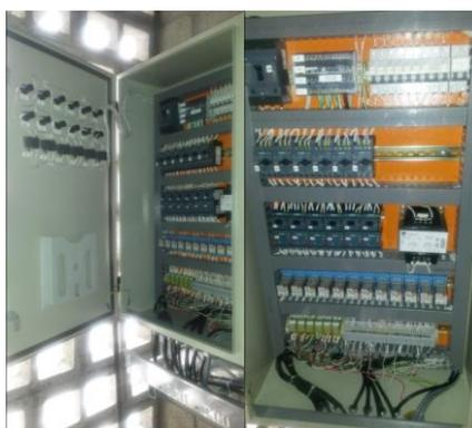
**Figura 93 Montaje de Gabinete Metálico**
