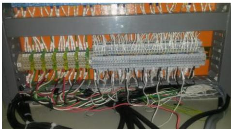
**Figura 85 Conexión de Borneras.**
