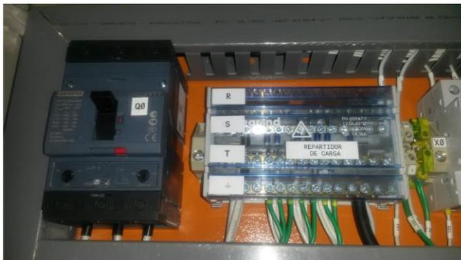
**Figura 91 Breaker Principal, borneras motor y Borneras de tierra.**
