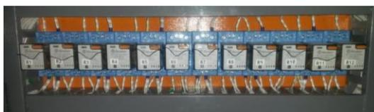
**Figura 86 Conexión de relés de 8 Pines.**
