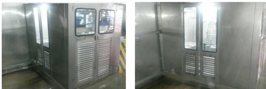
**Figura 82 Montaje de compuertas y acrilicos.**
