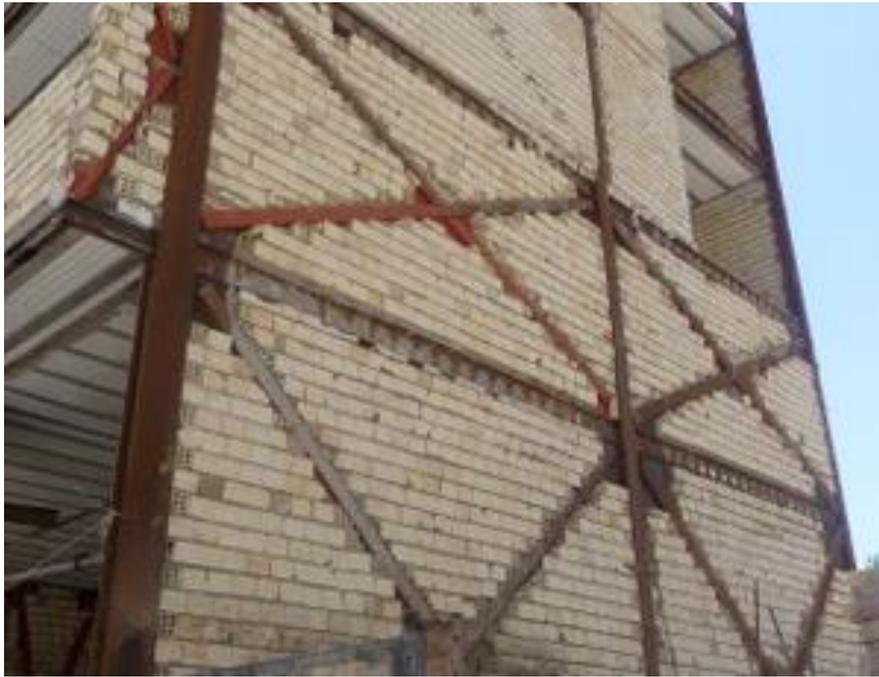
**Figura 9 Arriostramiento mediante diagonales en cruz**
