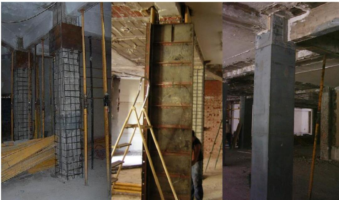
**Figura 5 Reforzamiento de columnas con recrecido de hormigón armado**
