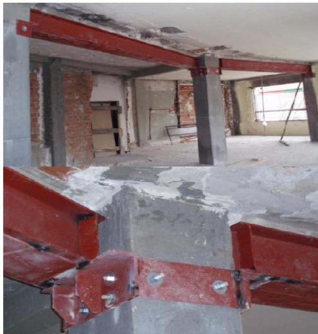
**Figura 6 Reforzamiento de vigas mediante colocación de perfiles metálicos**
