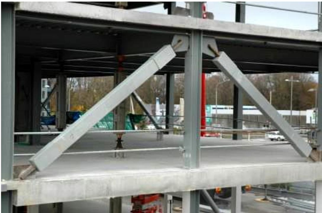
**Figura 8 Arriostamiento mediante diagonales simples**
