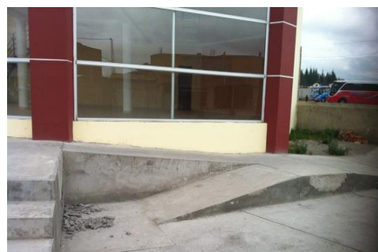
Figura 172 Rampa con obstáculos del terminal
