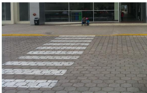
Figura 389 Pasos peatonal en la circunvalación
