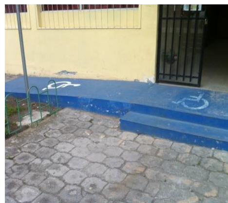
Figura 308 Rampa de la Facultad Mecánica
