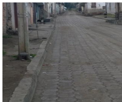
Figura 435 Acera con barreras urbanísticas
