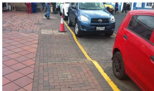
Figura 402 Vado vehicular adecuado en la zona remodelada del centro histórico
