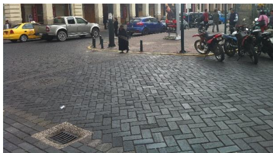
Figura 391 Falta de paso peatonal en la zona remodelada de la ciudad
