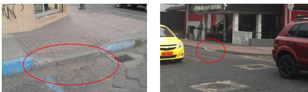
Figura 398 Vado peatonal adecuado
