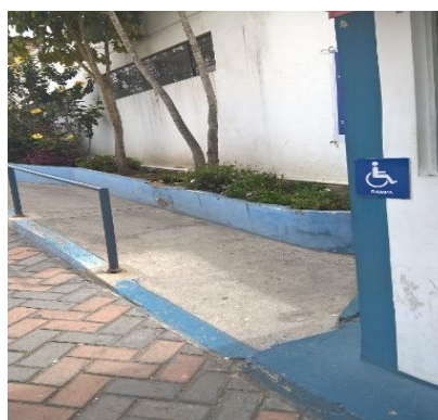
Figura 337 Rampa de la UNACH Campus 3
