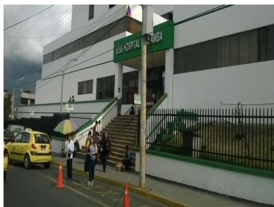
Figura 119 Entrada principal al Hospital del IESS
