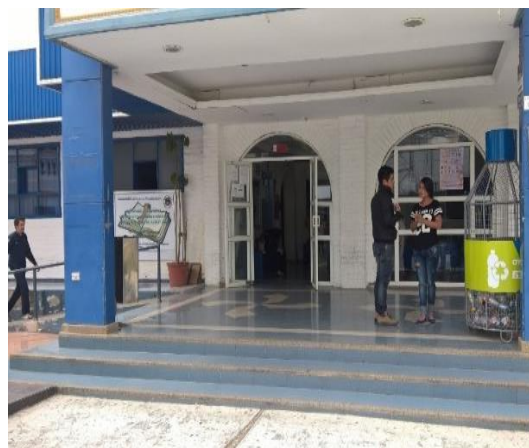
Figura 335 Gradas de ingreso sin rampa de la UNACH Campus 3
