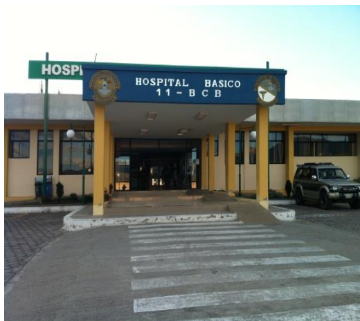
Figura 114 Hospital Básico No. 11-BCB- Galápagos
