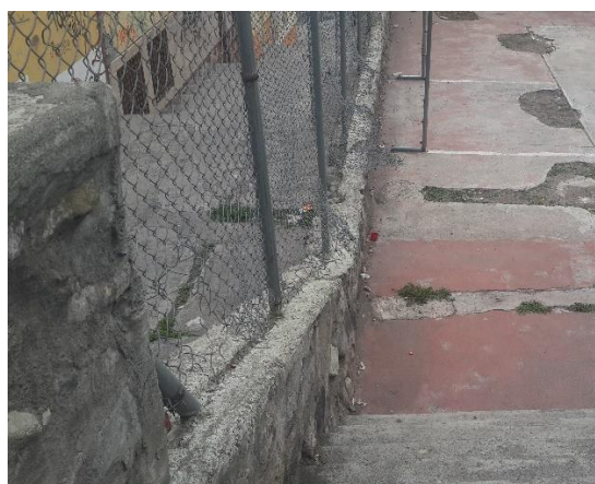
Figura 355 Cancha de Loma de Quito
