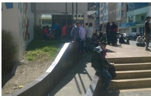
Figura 253 Rampa de acceso del Registro Civil
