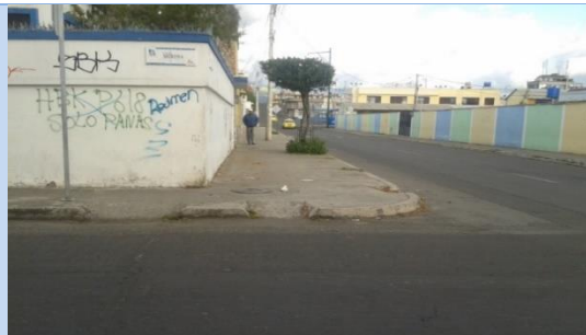
Figura 502 Vado peatonal en la zona no remodelada en el cantón Riobamba
