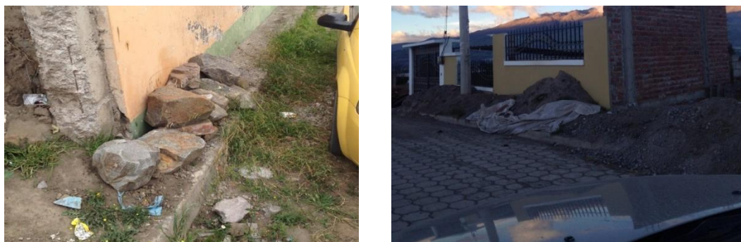
Figura 438 Aceras con obstáculos de accesibilidad en la parroquia Punín
