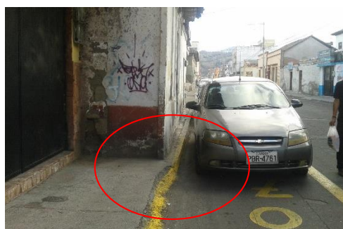
Figura 383 Acera muy angosta no permite el paso
