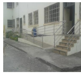
Figura 248 Escaleras del Jefatura de Salud zonal 3
