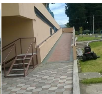
Figura 327 Rampa de la Fac. de Ingeniería
