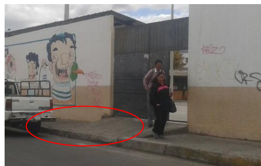
Figura 399 Vados vehiculares inadecuado
