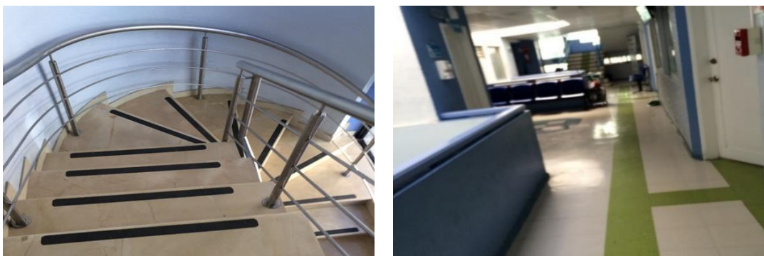
Figura 139 Escaleras y Pasillos de la Clínica Metropolitana
