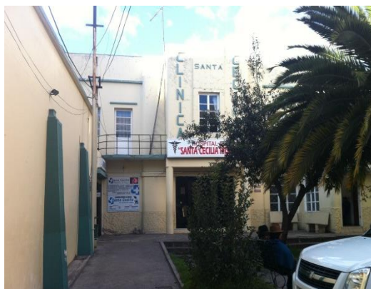
Figura 140 Rampa de la Clínica Santa Cecilia
