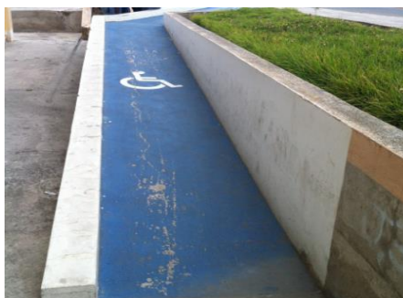
Figura 30 Rampa de acceso en la ESPOCH
