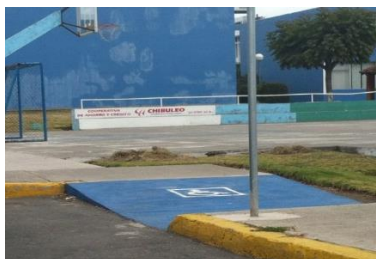
Figura 31 Rampa de acceso en la ESPOCH
