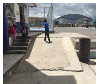
Figura 216 Rampa de la unidad educativa “Santo Tomás Apóstol”
