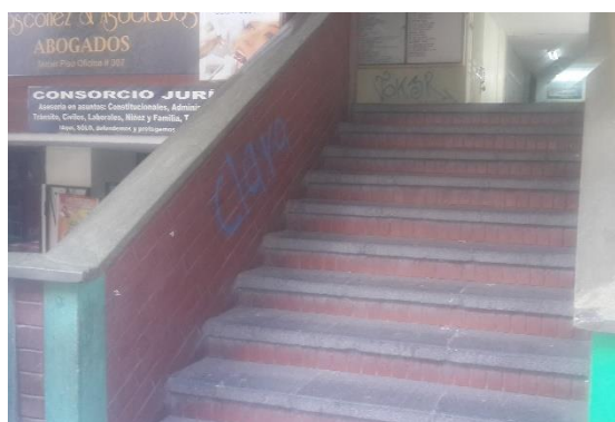
Figura 282 Escalera de la entrada del centro comercial Chimborazo
