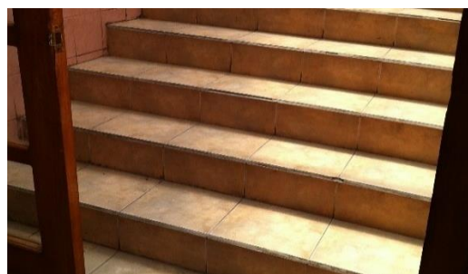
Figura 111 Escaleras del hospital Andino Alternativo de Chimborazo
