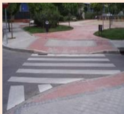
Figura 506 Vado peatonal adecuado en España
