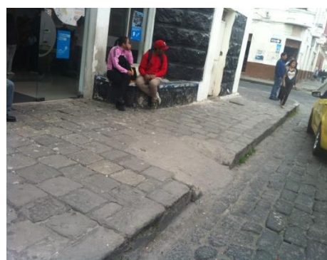
Figura 229 Rampa de acceso a la CNT
