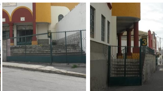
Figura 168 Entradas sin Rampa a la Plaza de Plaza de Toros Raúl Dávalos
