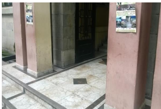
Figura 321 Entrada principal de la UNACH campus 1
