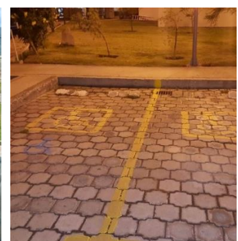
Figura 330 Parqueaderos para personas con discapacidad UNACH campus 2
