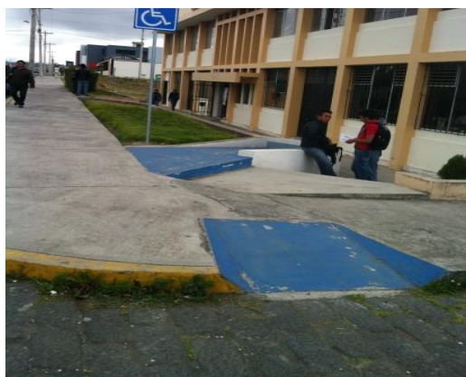
Figura 307 Rampa de la carrera de Mantenimiento Industrial
