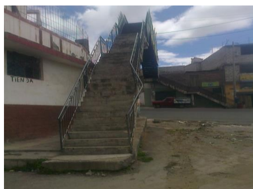
Figura 426 Puente peatonal a la entrada de la parroquia Lican
