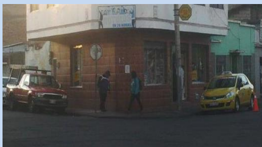
Figura 484 Esquina de una acera peatonal en el cantón Riobamba (Parroquias Urbanas)
