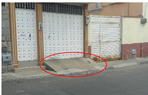
Figura 399 Vados vehiculares inadecuado
