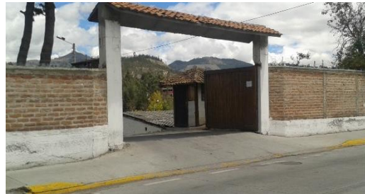
Figura 403 Vado vehicular adecuado en la zona remodelada de la circunvalación
