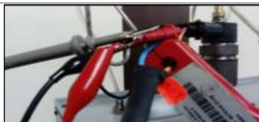
Figura 70 Conexión de la pinza amperimétrica
