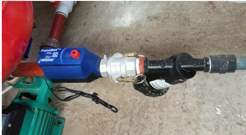
Figura 43 Electroválvula y filtro
