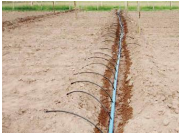
Figura 8 Conexión de tubería secundaria a tubería terciaria
