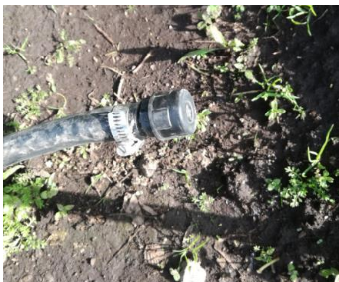
Figura 49 Final de manguera
