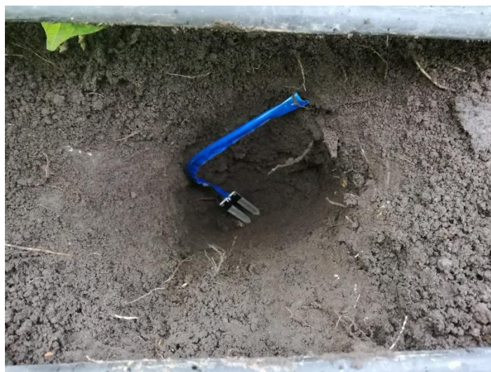
Figura 54 Colocación del sensor de humedad
