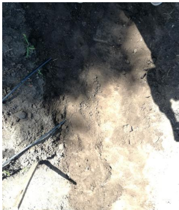
Figura 48 Enterramiento de manguera de polietileno
