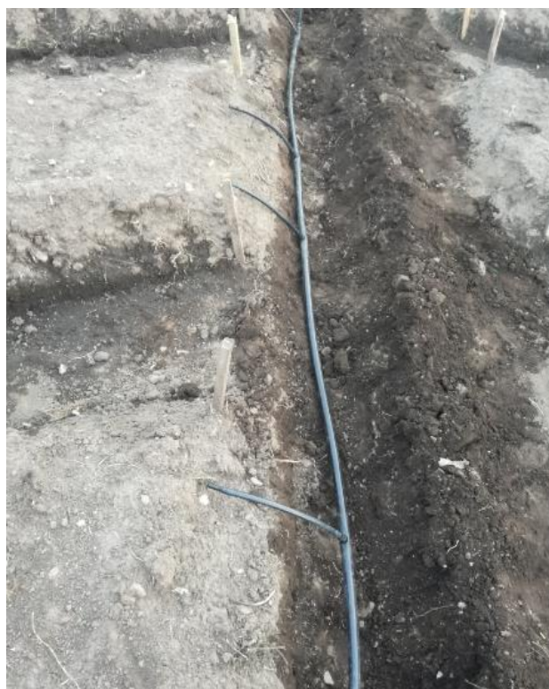
Figura 47 Manguera de polietileno, perpendicular a las camas
