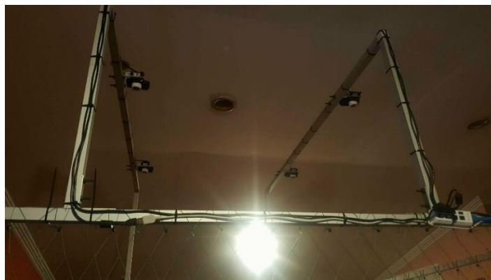
Figura 118 Implementación de estructuras para soporte de arreglo de cámaras
