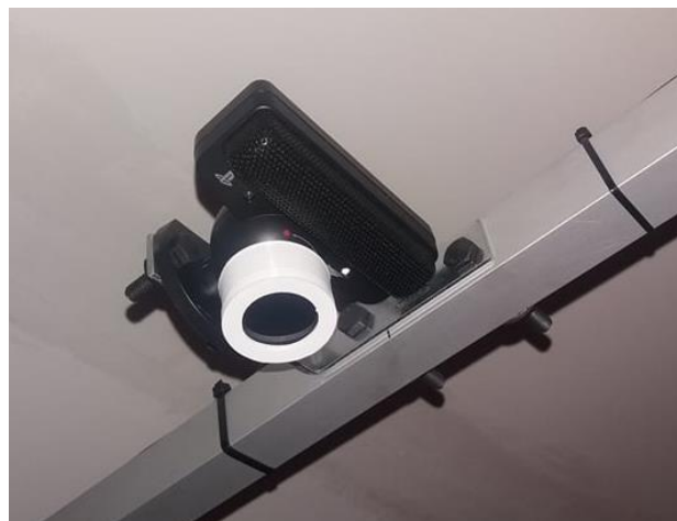
Figura 123 Filtro físico en cámara
