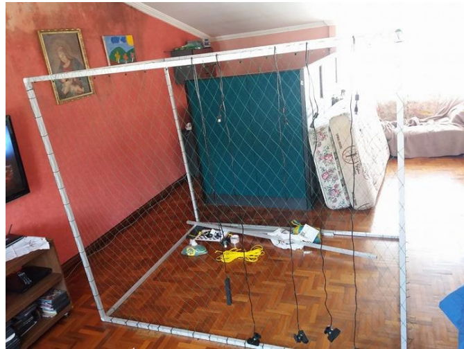
Figura 117 Implementación de red de seguridad a la estructura
