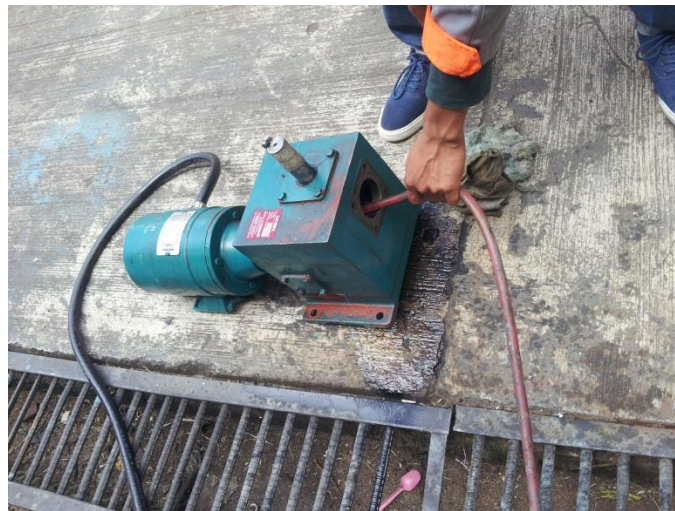
Figura 27. Limpieza interna de la caja reductora
