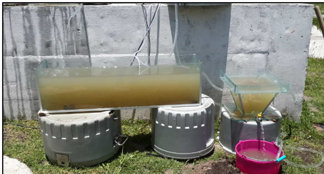
Figura 14 Instalación de Planta Piloto en el exterior de las instalaciones Fuente: Mónica G Pérez (2017)
