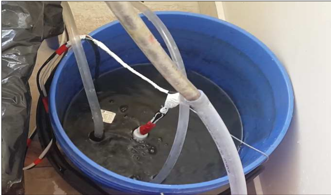
Figura 28 Instalación de flotador en balde para recirculación Fuente: Mónica G Pérez (2017)
