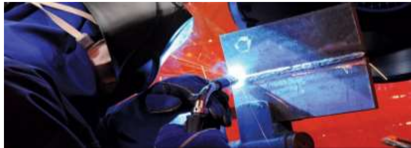
Figura 10 Soldadura de arco de gas con electrodo metálico (GMAW)
