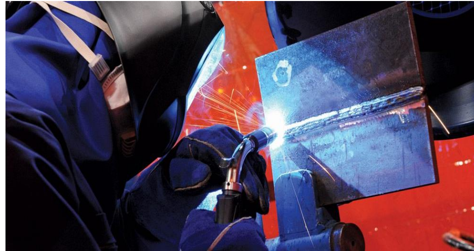
Soldadura de arco de gas con electrodo metálico (GMAW)
