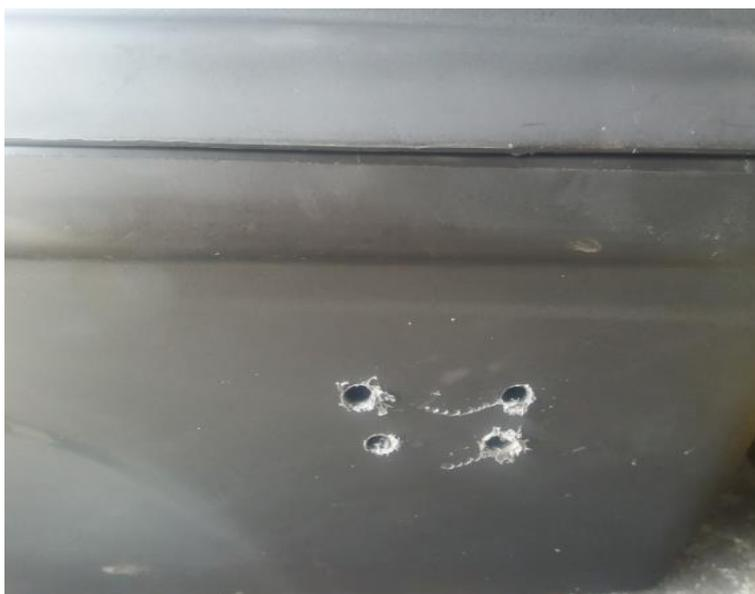
**Figura 46** Perforación del block de elementos
